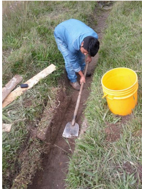
b. Limpieza, acondicionamiento y toma de medidas de los canales.
