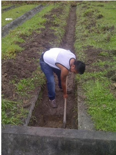
b. Limpieza, acondicionamiento y toma de medidas de los canales.
