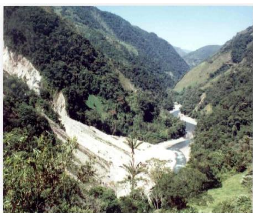
Figura 5. Deslizamiento Activo y Resesamiento parcial del río
