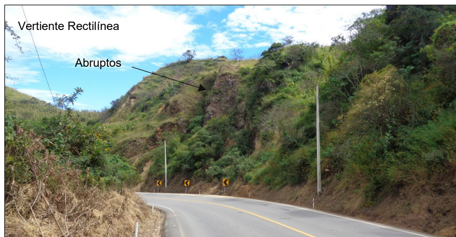
Figura 64. Vista general: Vertiente rectilínea con abruptos. Sector Pangarillas Fuente: El Autor, 2017.
