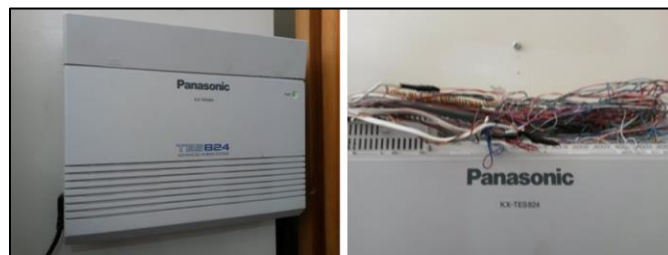
Fig. 43. Central de la facultad Agropecuaria Panasonic KX-TES 824. [Elaboración propia]
