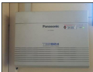
Fig. 36. Central de Bienestar Estudiantil Panasonic KX-TES 824. [Elaboración propia]
