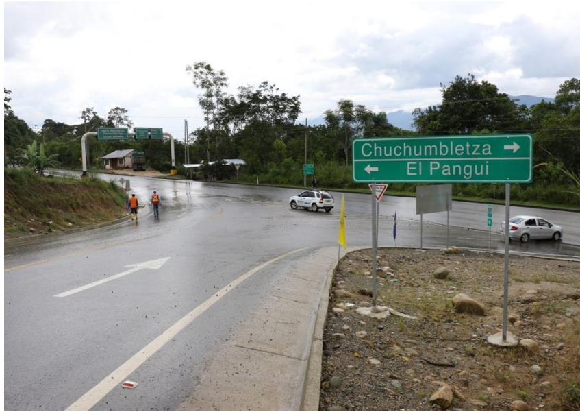
Fotografía 13. Asfalto de 14 km de vía Chuchumbletza – Tundayme – Proyecto Mirador por ECSA.
