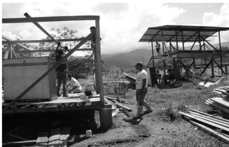
Fotografía 5. Derrocamiento de viviendas en los desalojos, 30 de Septiembre de 2015.
