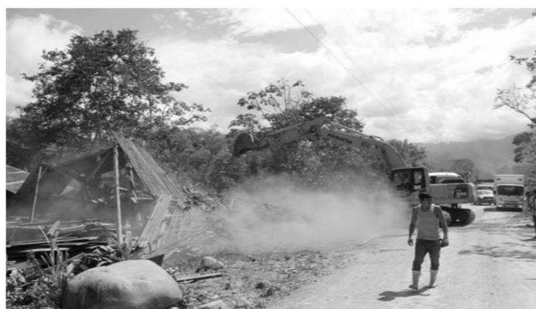
Fotografía 6. Propiedades destruidas con maquinaria durante los desalojos, 16 de Diciembre de 2015.
