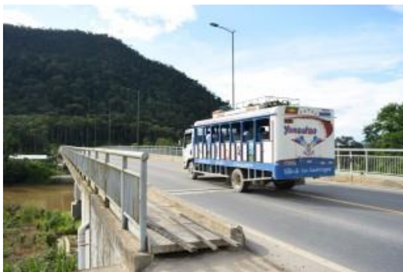
Fotografía 12. Puente carrosable y peatonal, construido por ECSA sobre río Zamora (Vía Tundayme)
