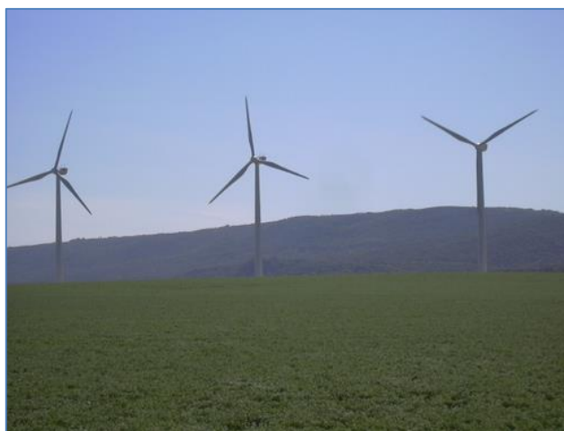
Figura 4. Central Eólica San Cristóbal
