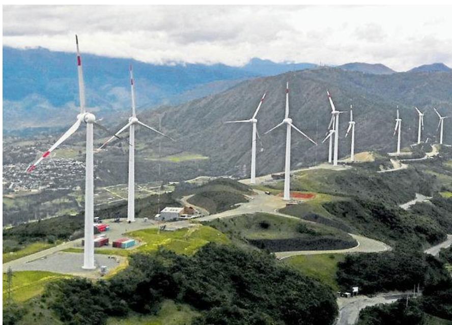
Figura 7. Parque Eólico Villonaco
