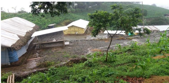
Fotografía 1. Instalaciones existentes en la zona
