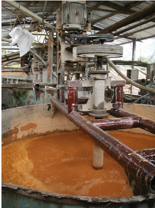
Fotografía N° 3: Tanque de Cianuración
