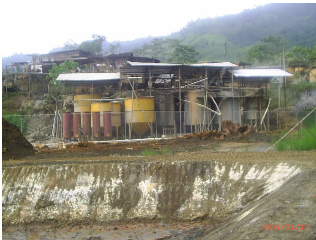
Fotografía N° 1: Vista General de la Planta
