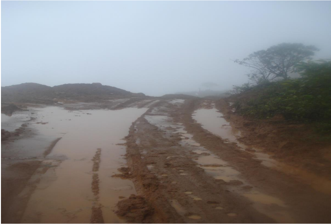
Foto vía de acceso al Área minera La Tigra.
