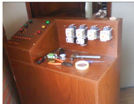
Foto3. Instalación de contactores.
