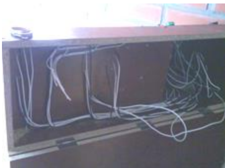
Foto 4. Ordenación del cableado interno.
