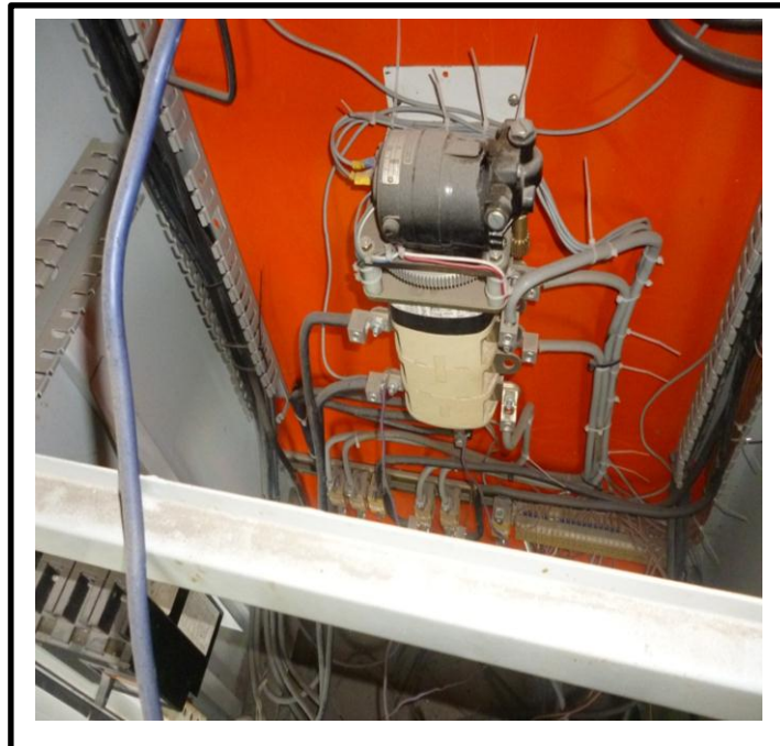
Figura 83. Montaje y pruebas de Transferencia automática
