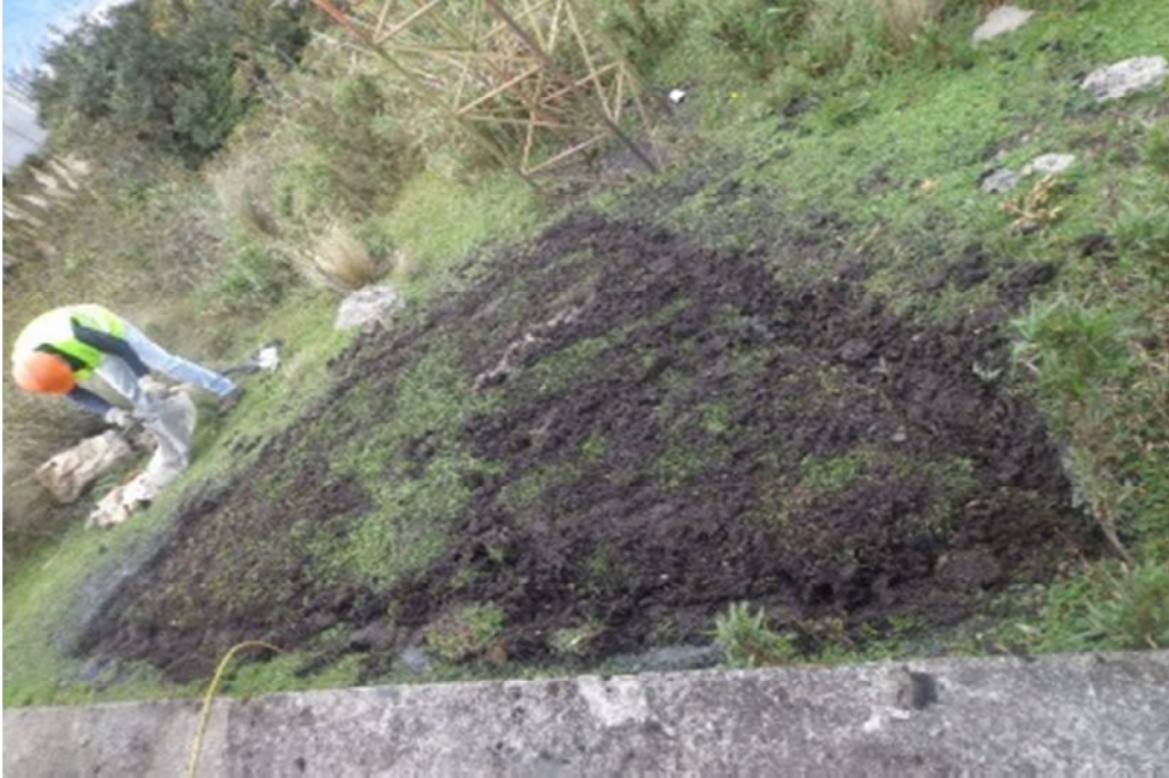
Fig. 47: Malla lista con tratamiento de suelo.
