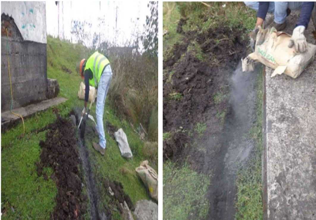
Fig.46: Realizando el tratamiento del terreno con cemento conductivo SAN-EARTH.
