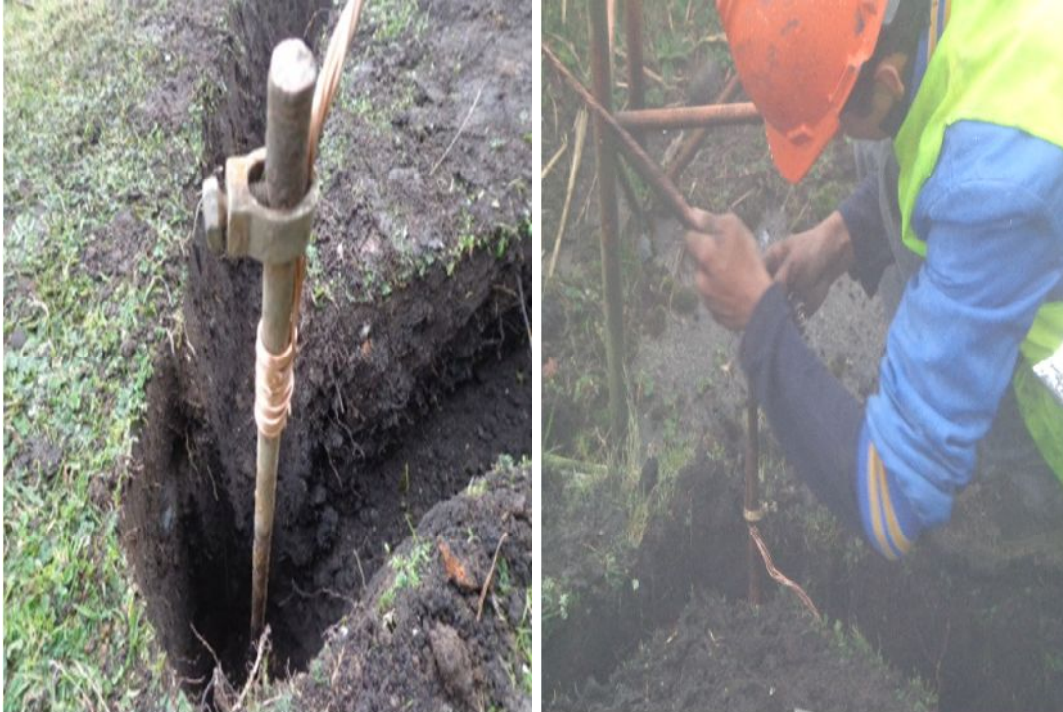
Fig. 45: Realizando las conexiones con conectores cooperworld.
