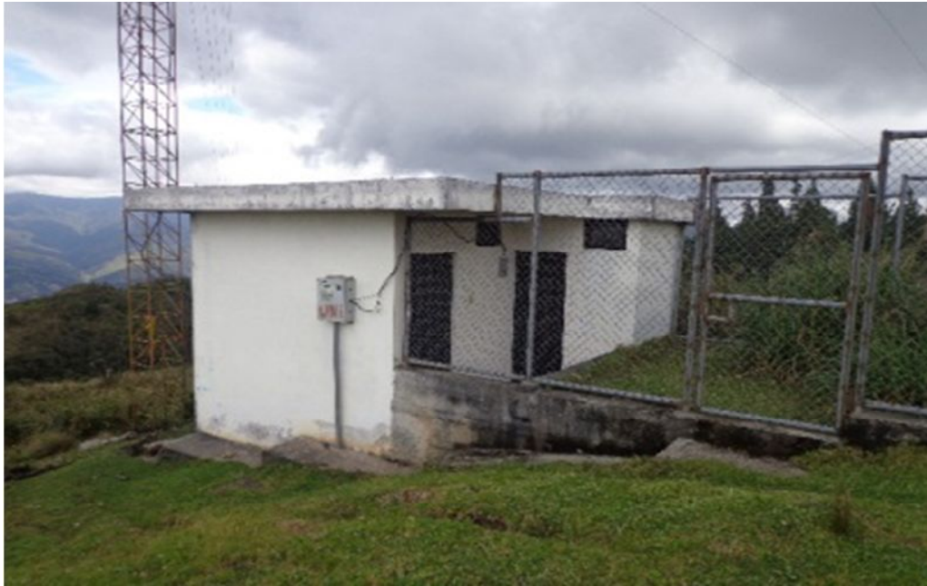
Fig. 39: Cuarto de equipos Radio Universitaria.
