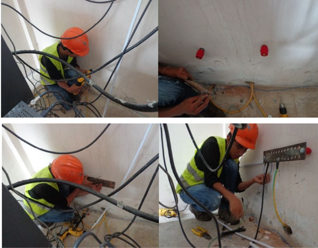
Fig. 49: Realizando la instalación de la barra.
