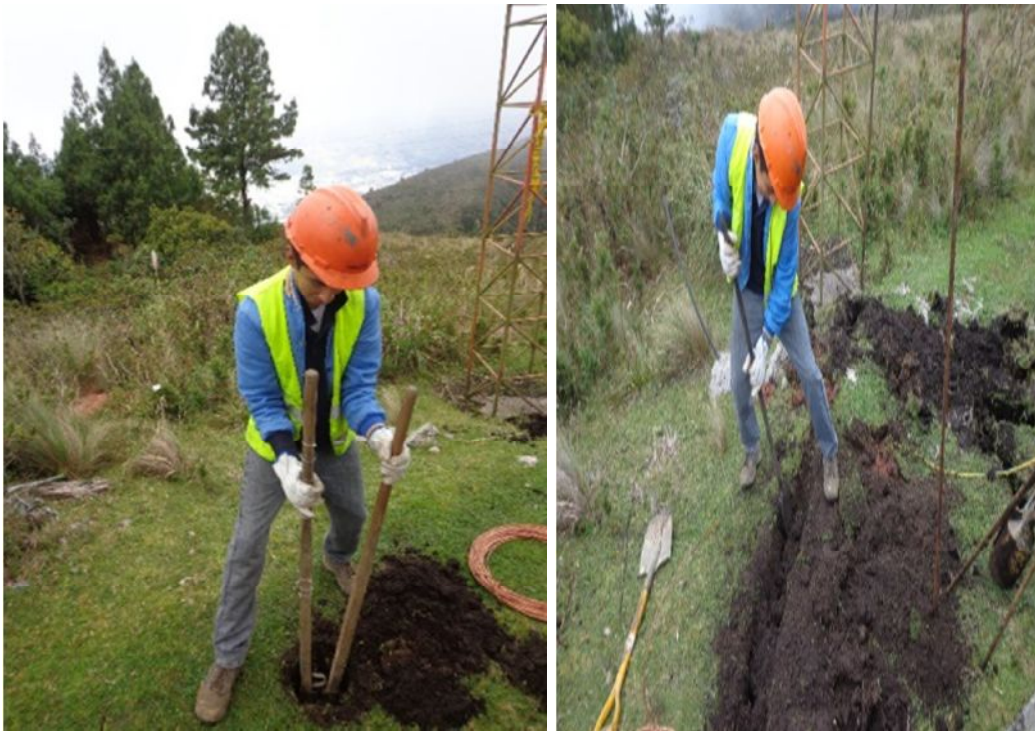
Fig. 40: Preparando el terreno para el SPT.
