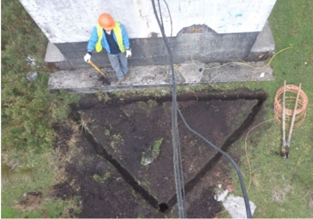
Fig. 41: Zanja para enterrar el cable.
