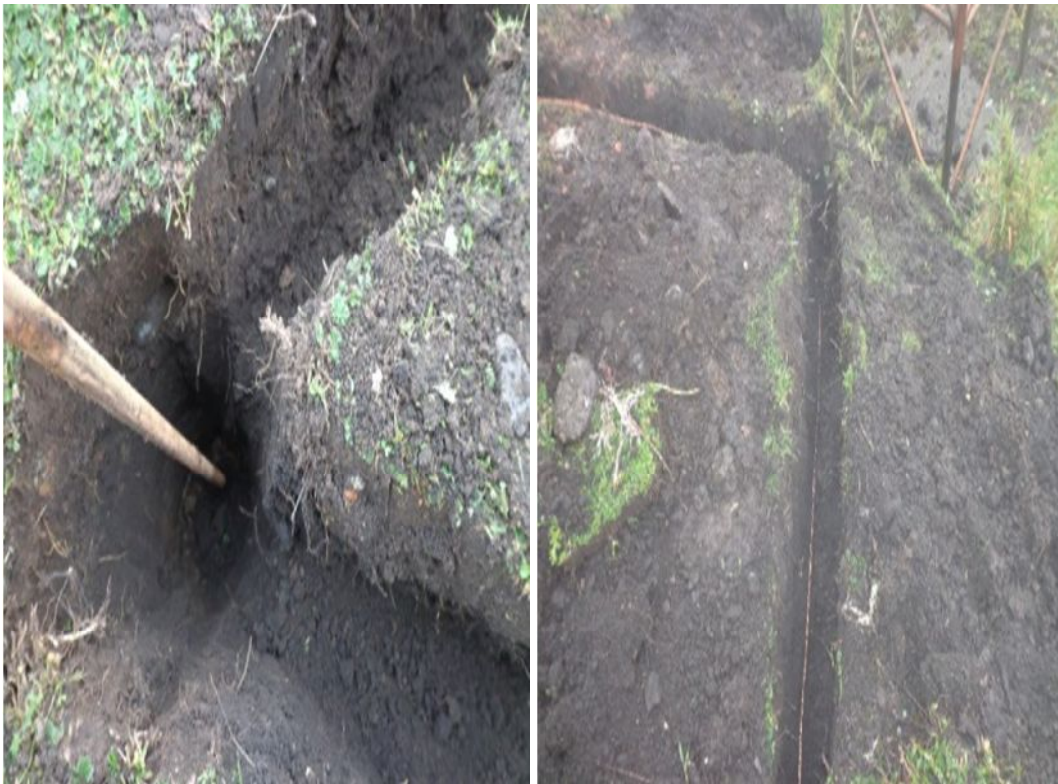
Fig. 44: Instalando cable y varillas en el SPT.
