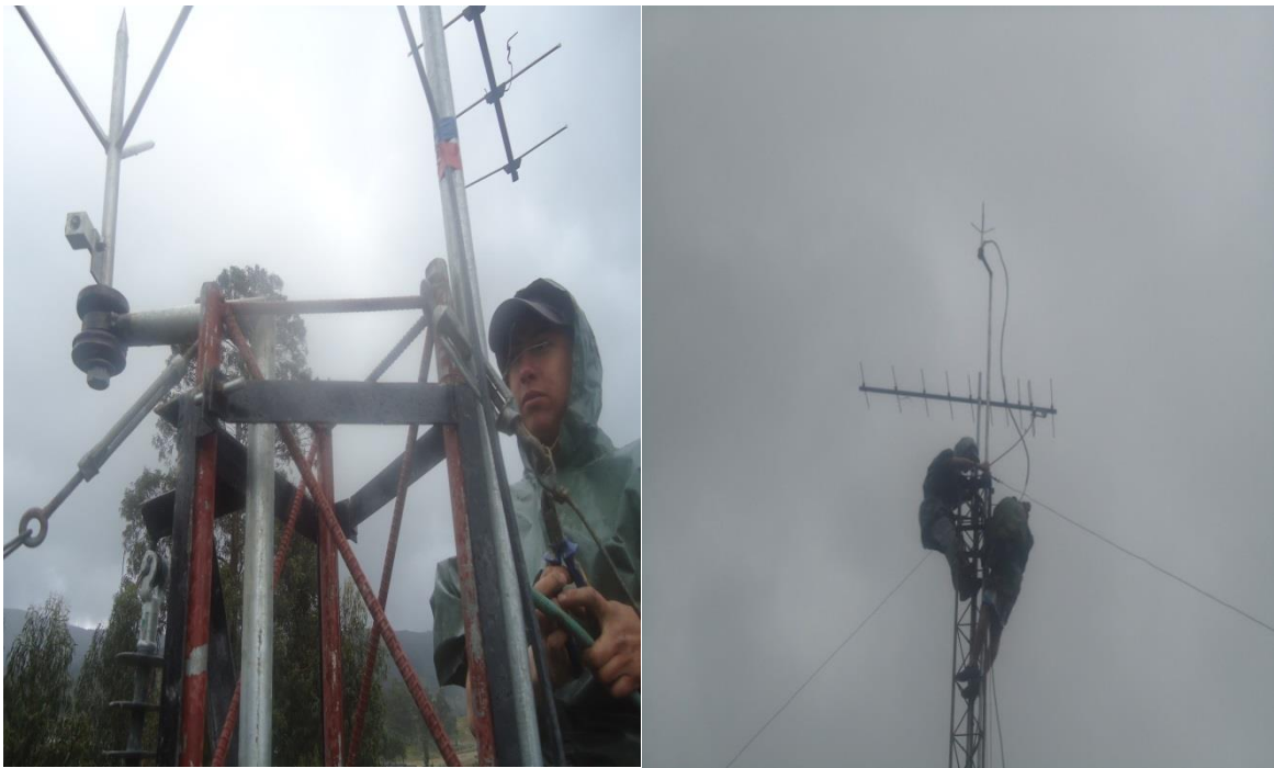
Figura. 43: Ensamble del pararrayos en la torre
