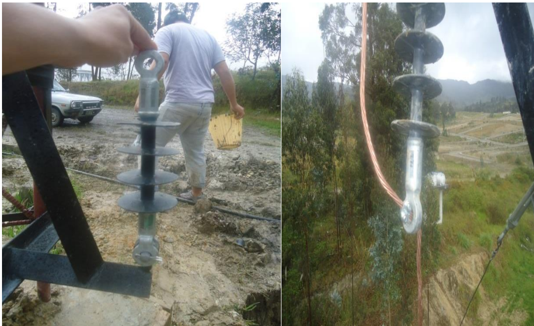
Figura. 44. Tensores del conductor bajante
