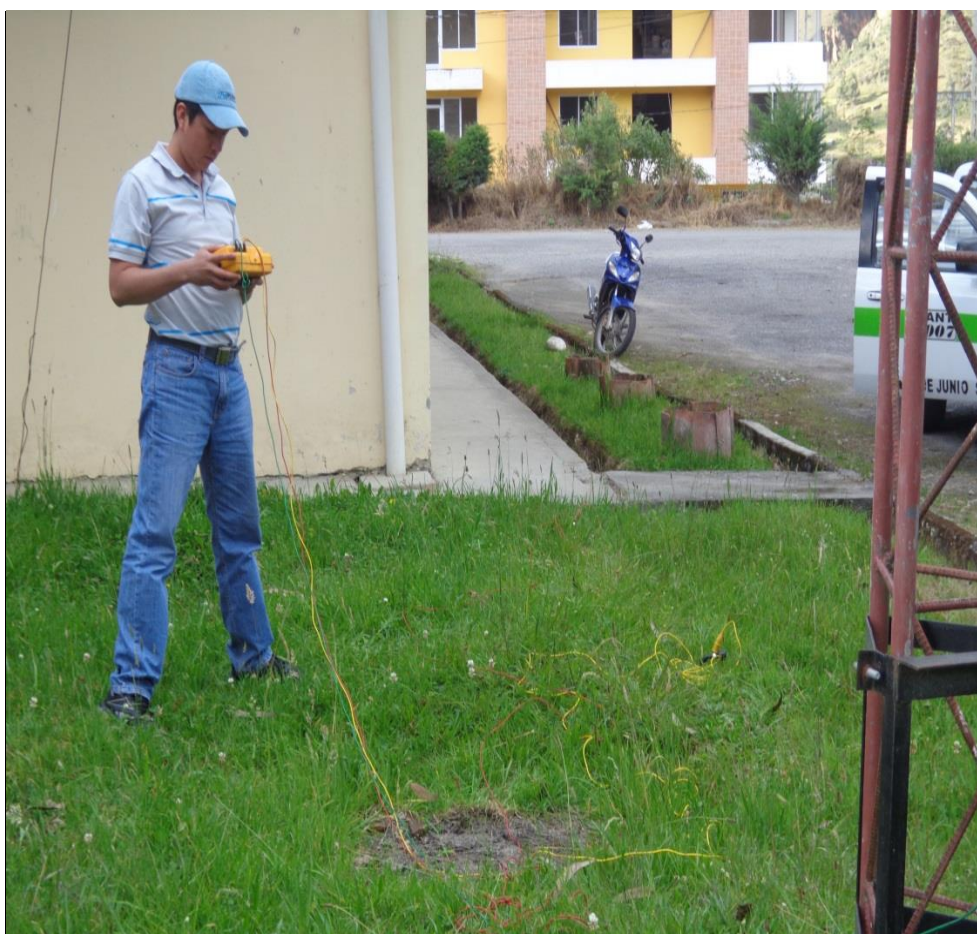
Figura. 48: Cables dispuestos en el terreno y comunicados con la malla
