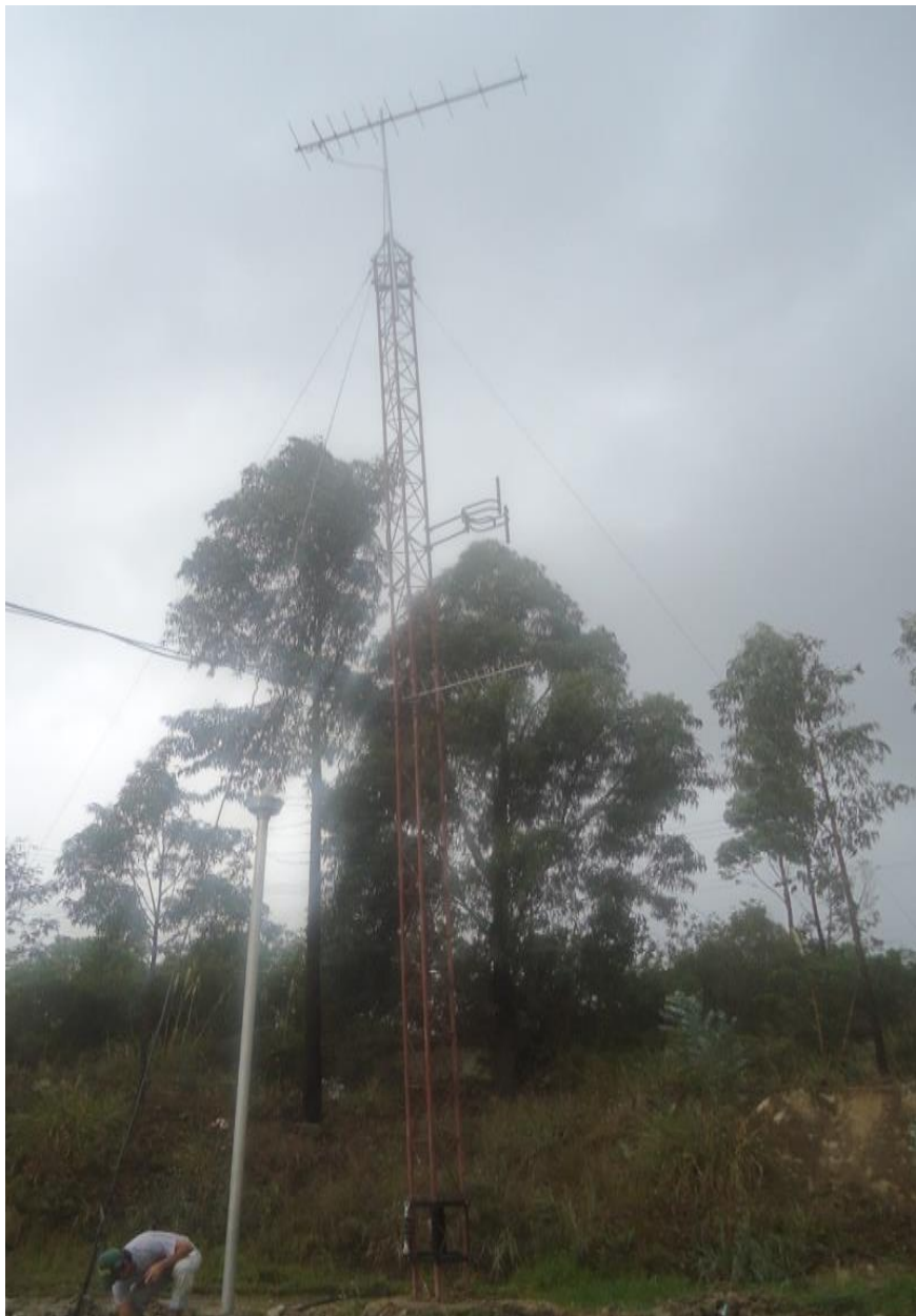
Figura.21: Torre a ser intervenida
