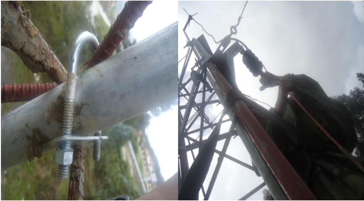
Figura. 45: Fijando el mástil y tensando el conductor bajante
