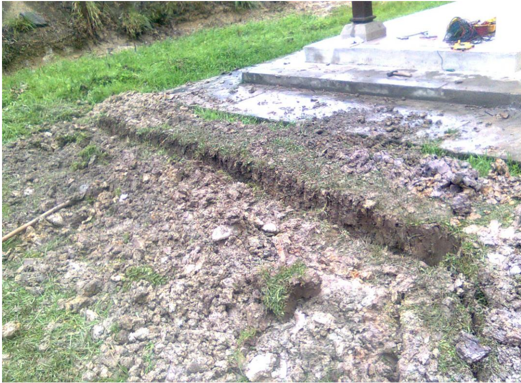
Figura. 31: Zanja para enterrar el cable
