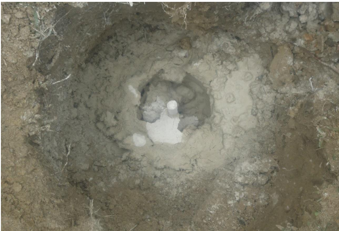
Figura. 36: Proceso final varilla fusionada con el terreno
