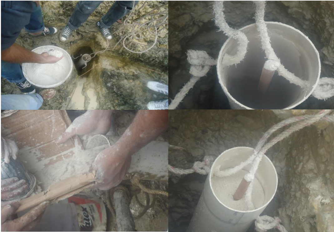
Fig. 35: Colocando cemento conductivo a las varillas copperweld
