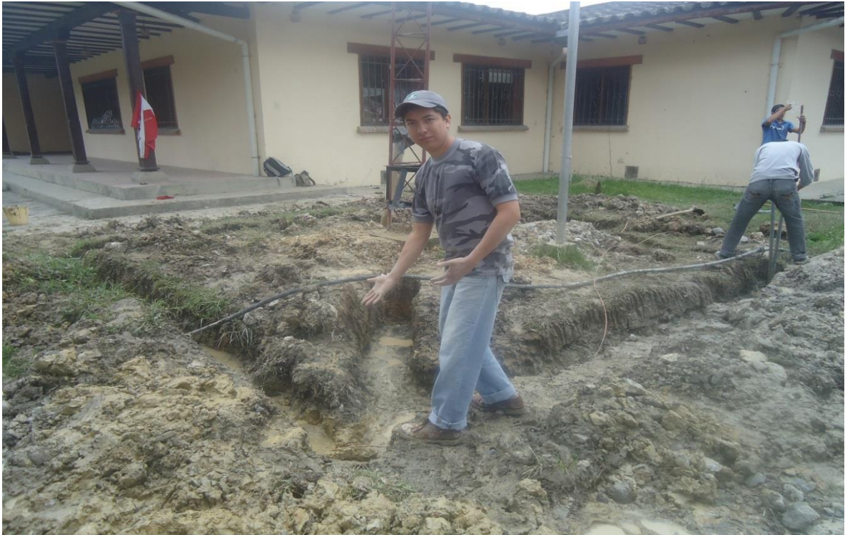
Figura. 33: Zanjas para la malla y hoyos para las varillas
