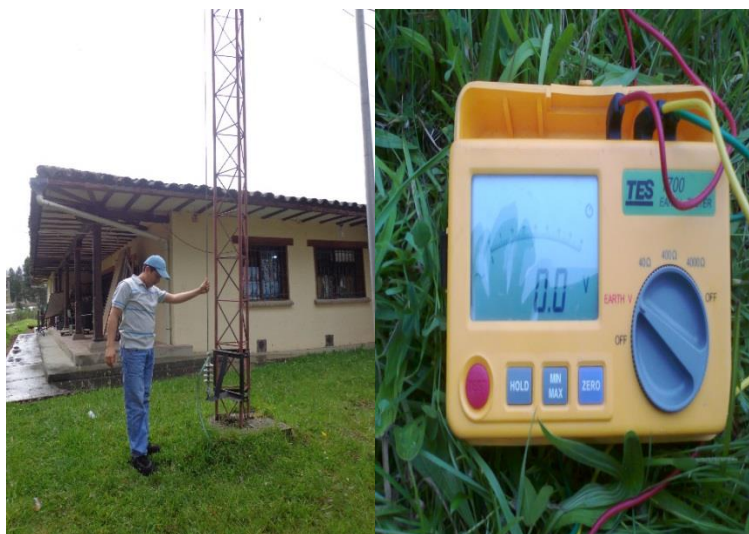
Figura. 47: Procediendo a medir la resistencia de puesta a tierra con el Tes1700
