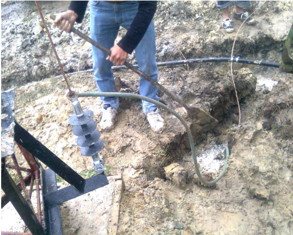
Figura. 358 Procediendo a conectar el conductor bajante con la malla
