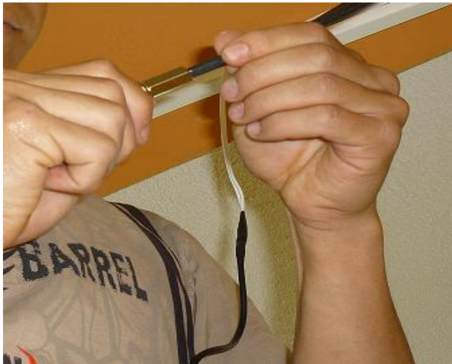
Conexión de conectores BNC
