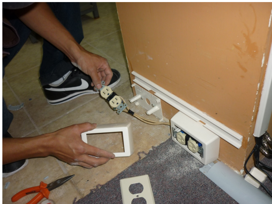
Instalación de las Cajas de Alimentación Anexo 8
