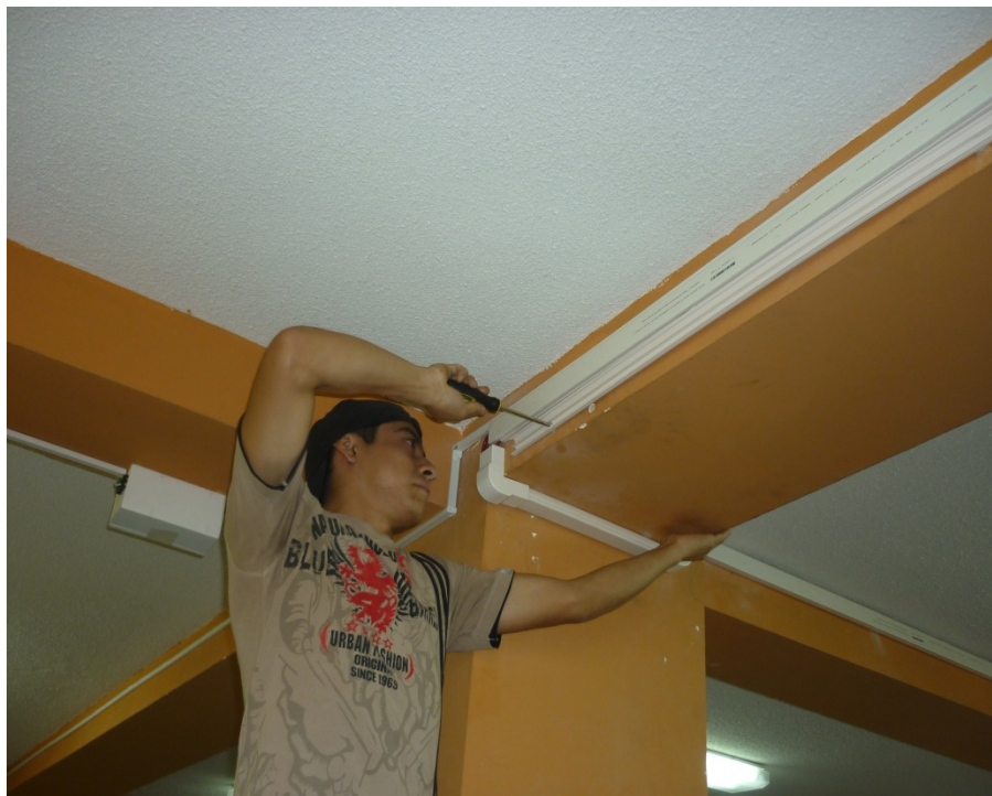
Aseguramiento de Canaletas con tornillos
