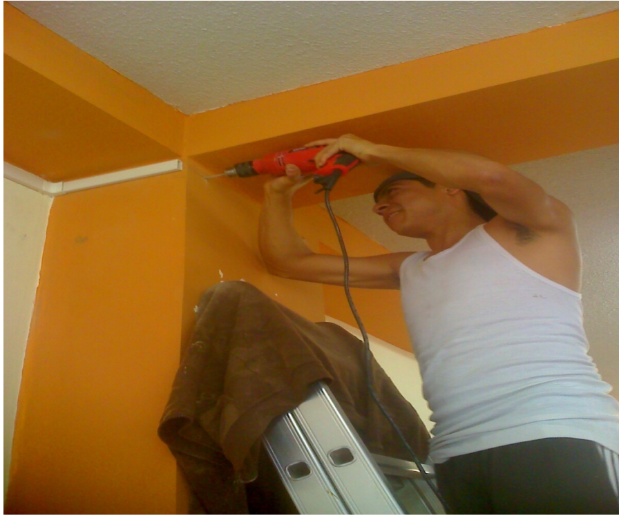
Ubicación de Canaletas
