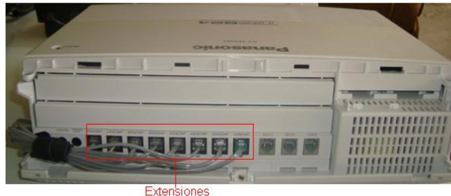
Fig.14 Ubicación de los jacks de las extensiones.
