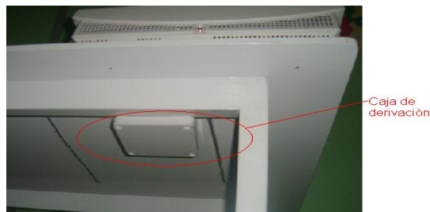
Fig.9 Colocación de la caja de derivación.
