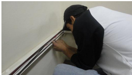
Fig.30 Colocación de cable en la canaleta existente
