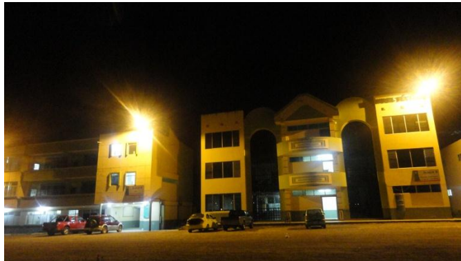
Fig.27 Nivel Técnico y Laboratorio de Telecomunicaciones
