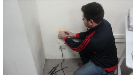
Fig.31 Colocación de cajetín sobrepuesto
