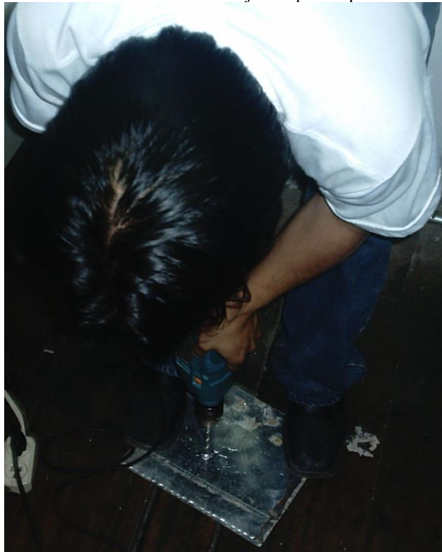
Figura 126. Realización de orificios para sujetar las partes de la antena
