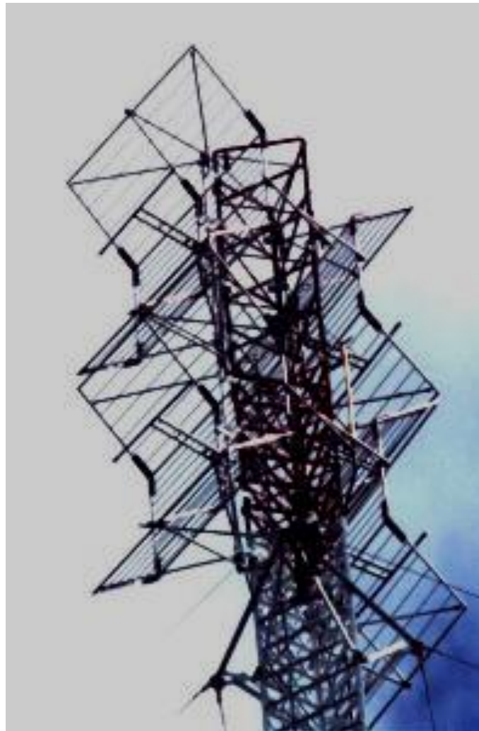
Figura 98. Antenas diedricas de dipolo de media onda
