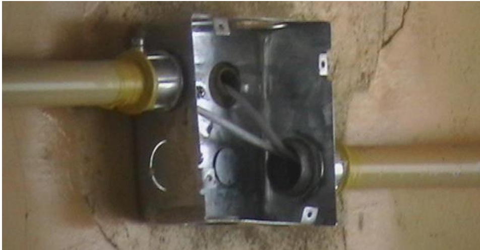
Figura 19: Caja de distribución y tubo EMT de 1'
