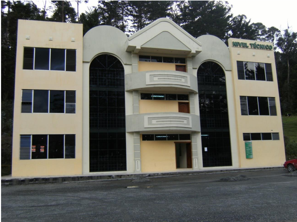
Figura 68: FOTO DEL EDIFICIO DONDE SE REALIZÓ EL TRABAJO
