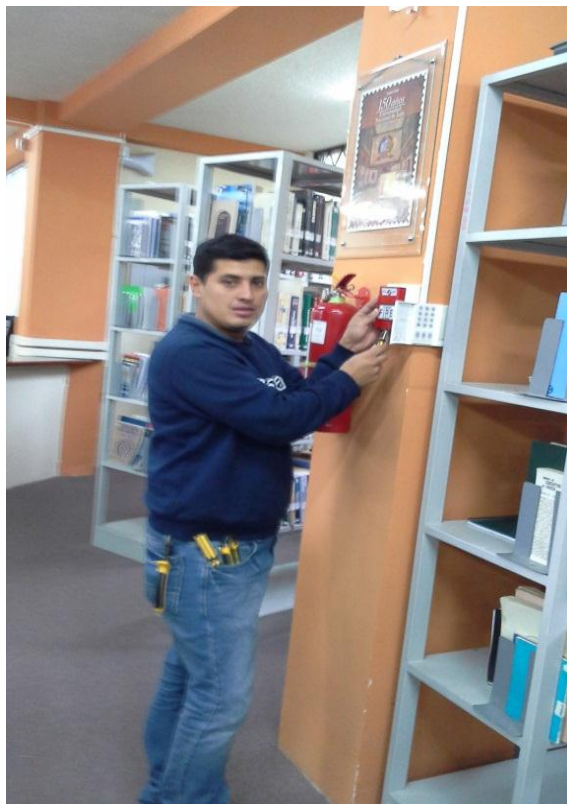
Figura 4.1 Proceso de Instalación
