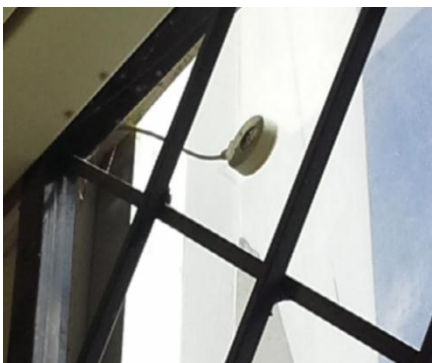
Figura 9.9. Sensor de Golpe o Ruptura de Cristal
