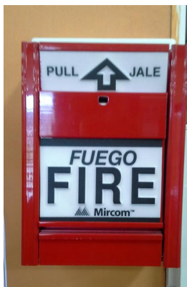
Figura 9.8. Estación Manual Simple
