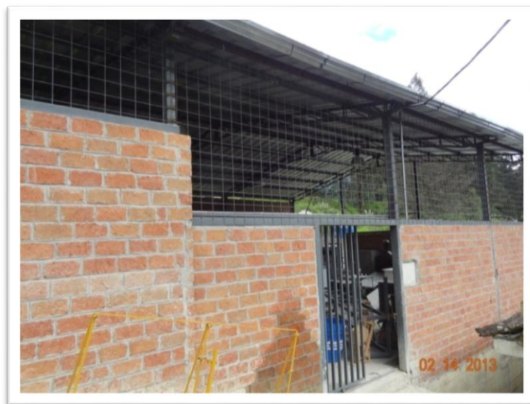
Fig. 1 Fachada del Laboratorio
