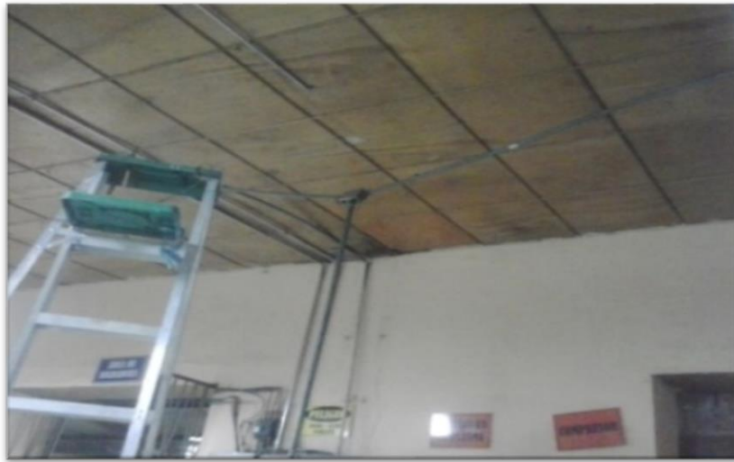
Figura 35. Desmontaje de tubería pvc
