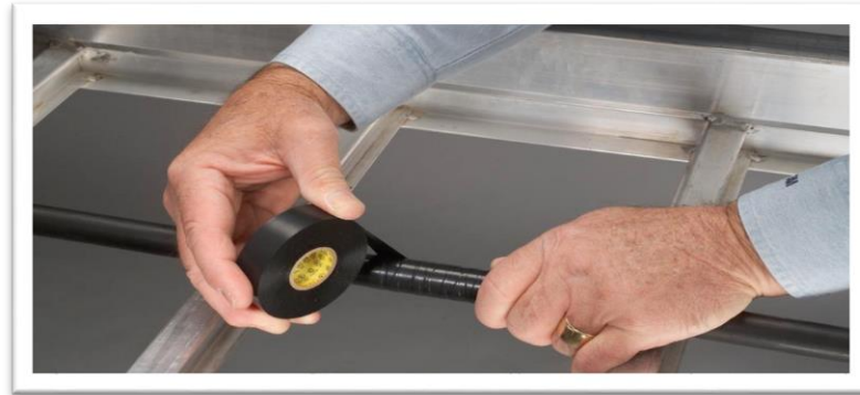
Figura. 23 Demostración como se debe colocar la cinta aislante en un empalme.
