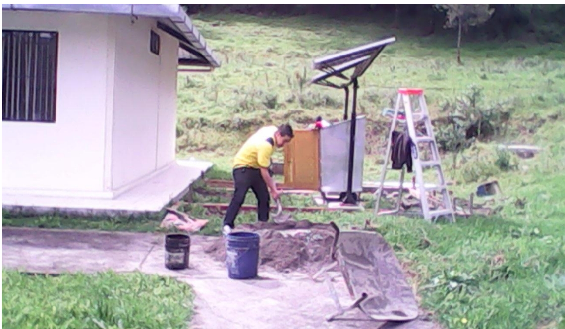
Remodelación del piso.
