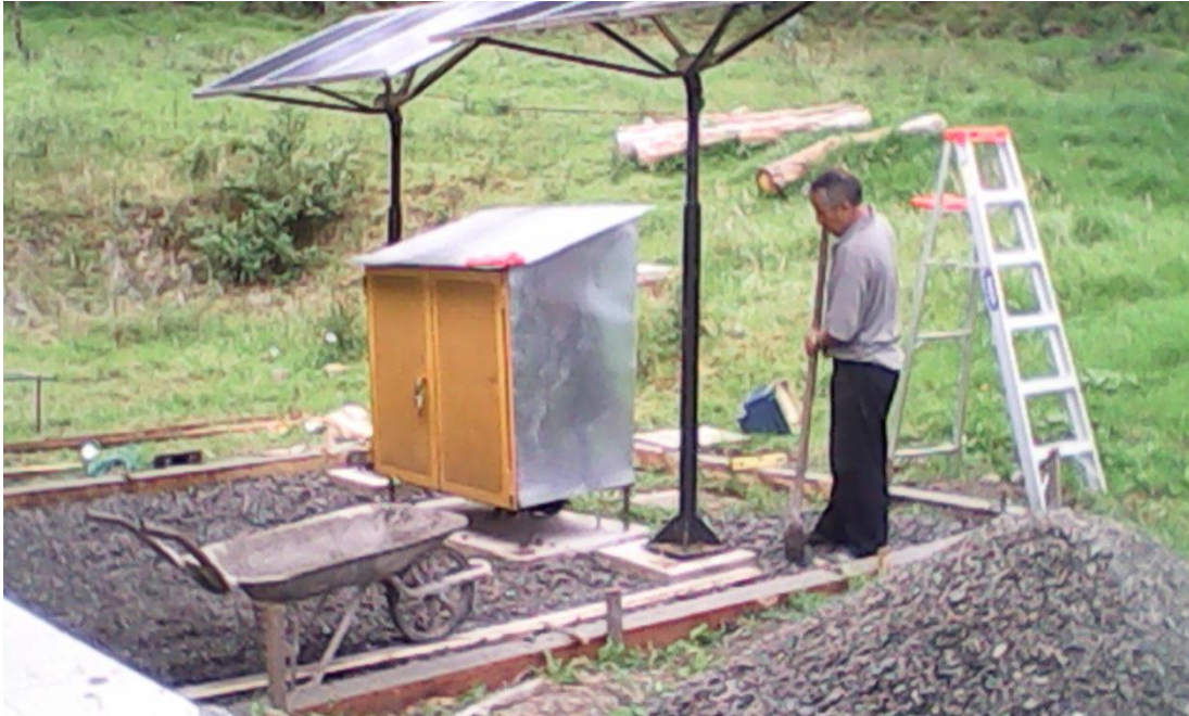
Colocación de gravilla en el piso del sistema fotovoltaico.
