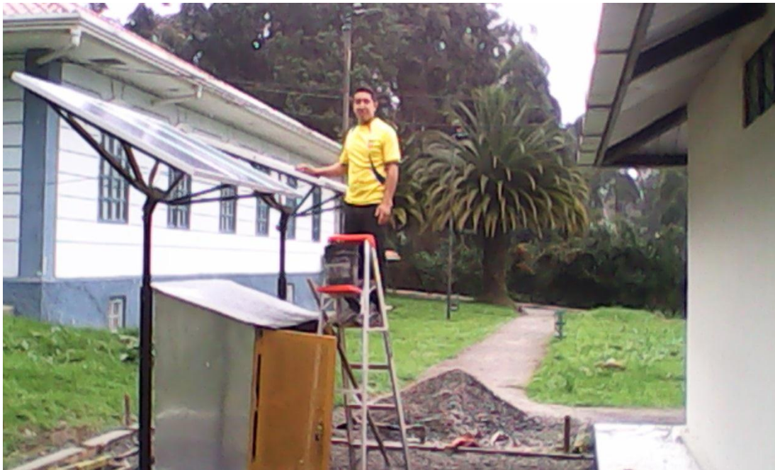
Mantenimiento del sistema fotovoltaico.
