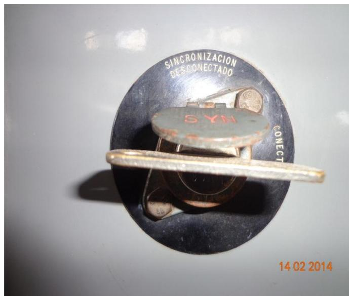
**Figura 90.-** Interruptor del sincronoscopio
