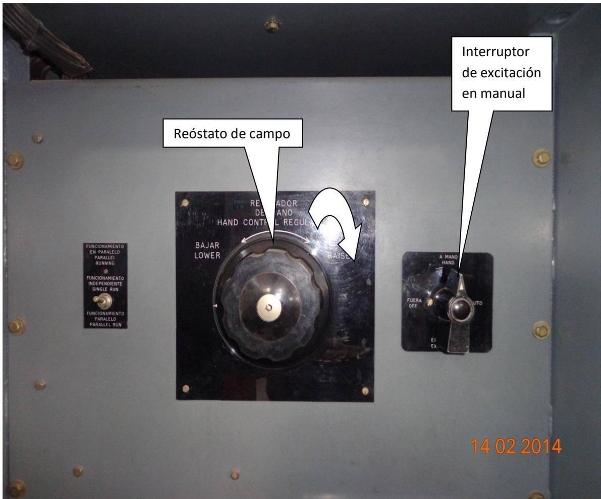
Figura 88.- Reóstato de campo e Interruptor de excitación en manual
