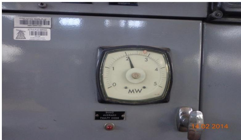
**Figura 76.-** Kilowatímetro
