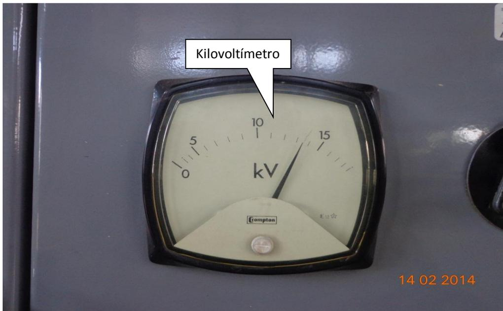
**Figura 80.- Kilovoltímetro**
