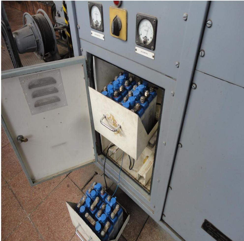
Figura 106.- Celdas de batería
