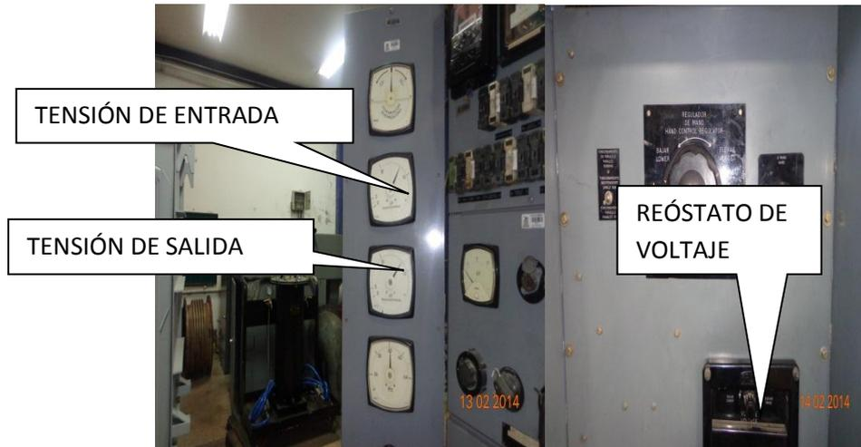
**Figura 91.-** Reóstato de voltaje
