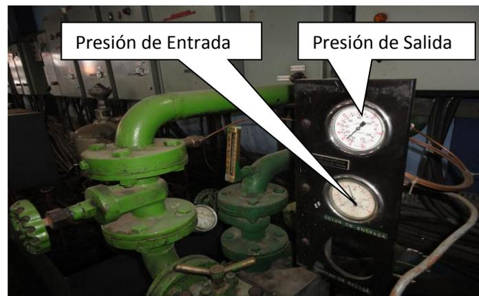
Figura 74.- Presión de entrada y salida de Jaulas de Válvulas
