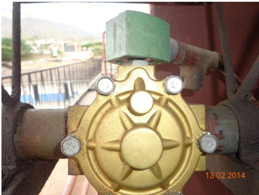
**Figura 63.-** Válvula solenoide eléctrica
