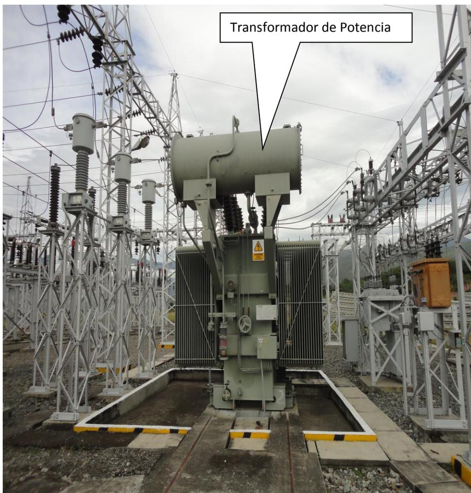
**Figura 95.-** Transformador de Potencia
