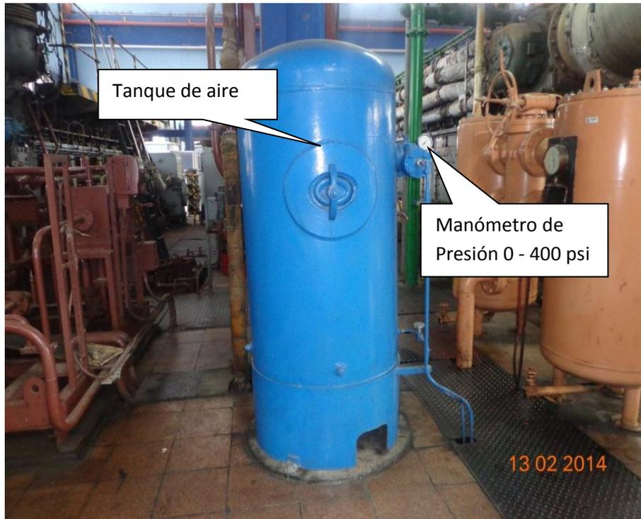
**Figura 82.-** Tanque de Aire
