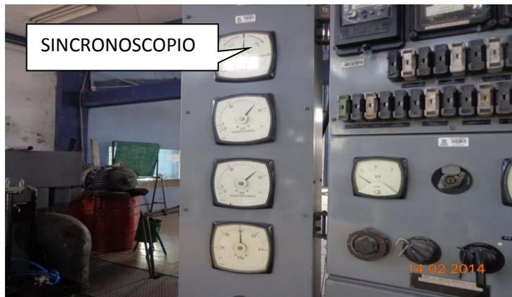
**Figura 92.-** Sincronoscopio
