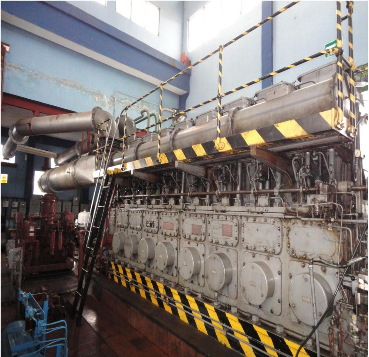
**Figura 42.-** Motor grupo electrógeno Mirreles Blackstone
