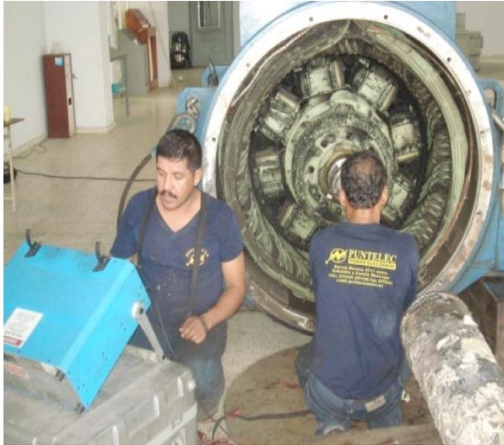
**Figura 40.-** Mantenimiento de un Alternador
