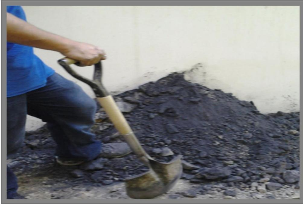
**Figura 31.** Mezcla para el tratamiento puesta a tierra
