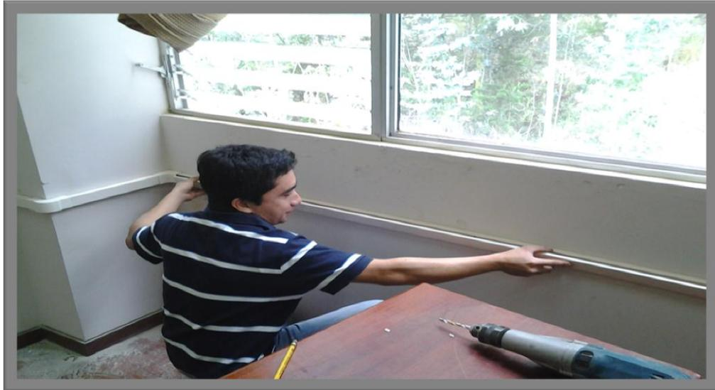
**Figura 24.** Montaje de canaletas y accesorios adicionales.
