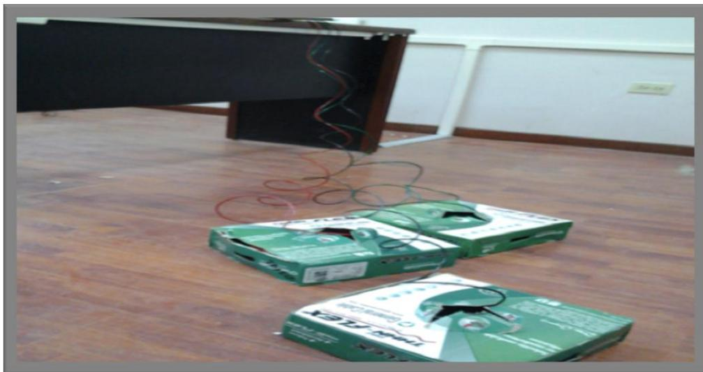
**Figura 25.** Tendido de conductores eléctricos.
