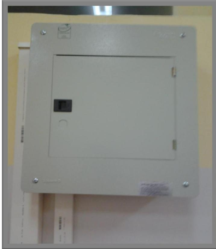
**Figura 27.** Montaje de caja térmica de distribución
