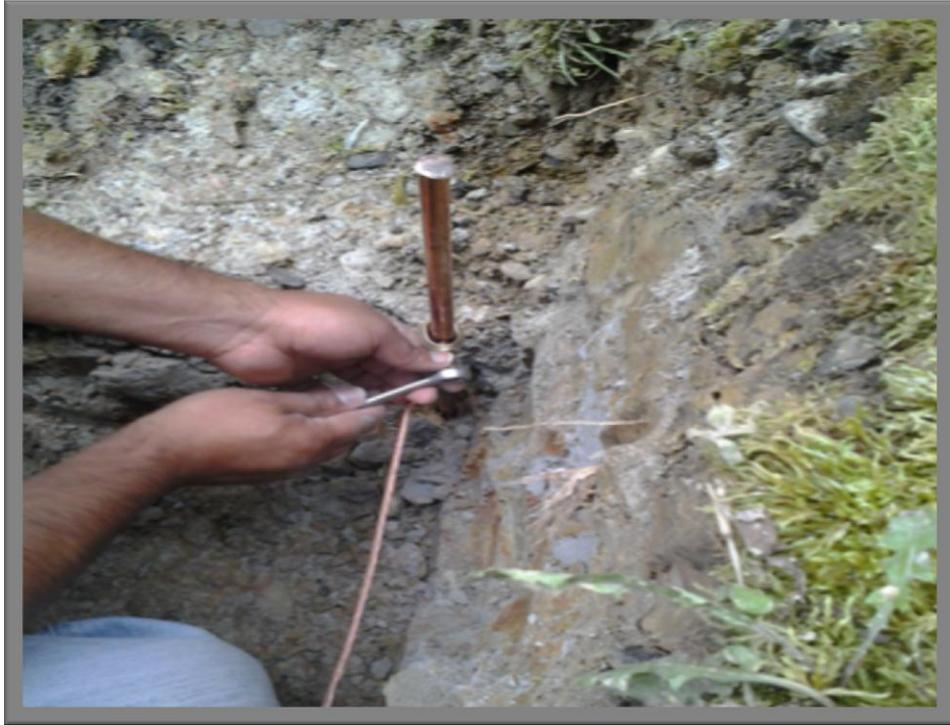
**Figura 29.** Montaje e Instalación de puesta a tierra
