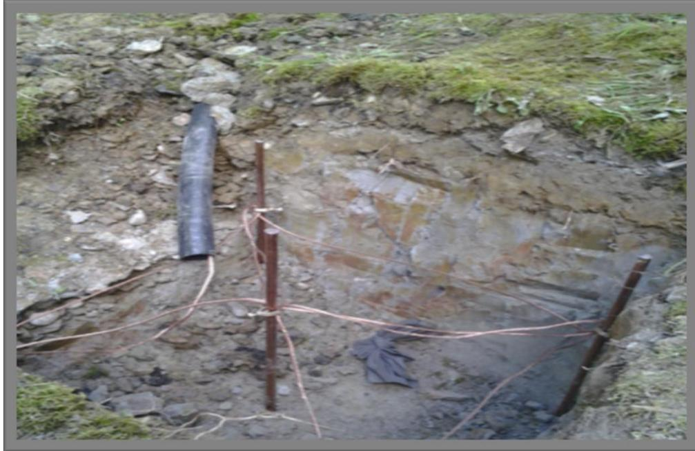
**Figura 30.** Montaje e Instalación de puesta a tierra
