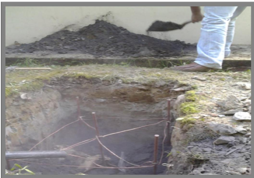
**Figura 32.** Se enterró los electrodos-varillas cooperweld con la mezcla de cemento conductivo con tierra.
