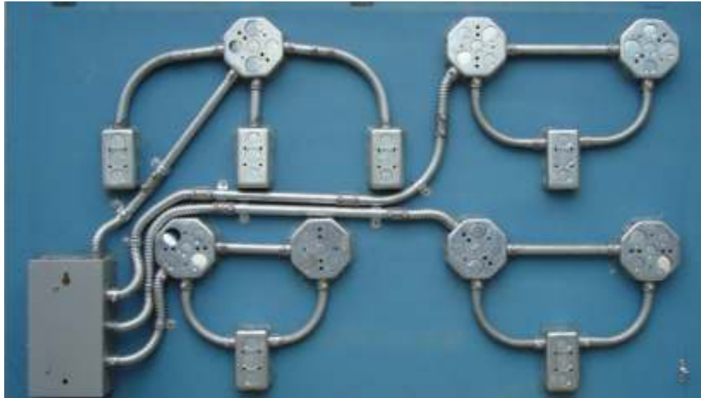
Figura 2.3.- Distribución de los circuitos
