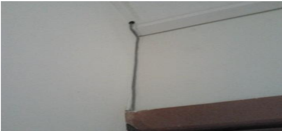
Fig. 16 Tendido de cable puerta principal
