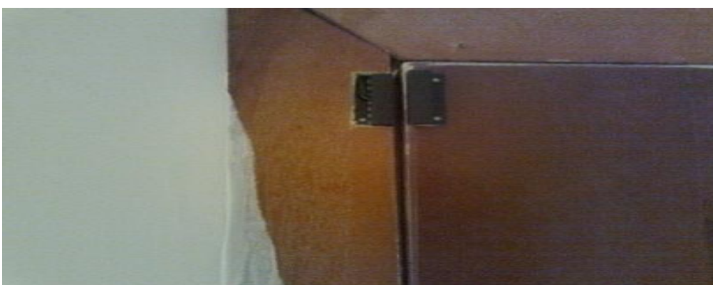
Fig. 21 Colocación de contactos magnéticos
