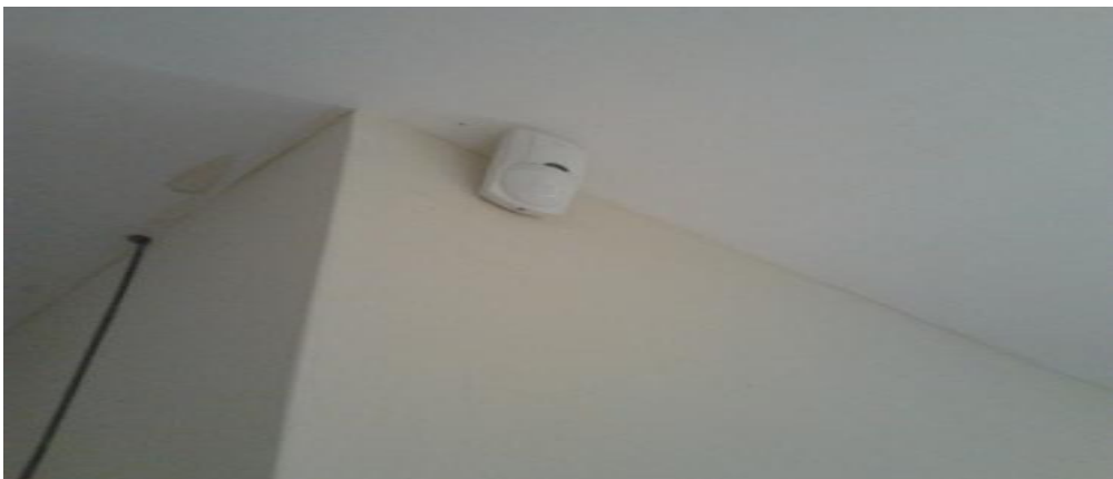
Fig. 23 Colocación de sensor movimiento oficina-secretaria
