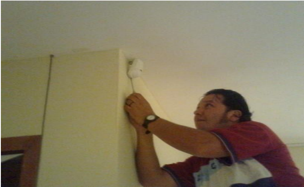
Fig. 28 Calibración de sensor de movimiento
