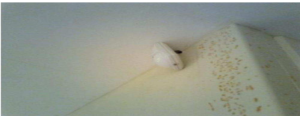
Fig. 20 Colocación de sensores de movimiento
