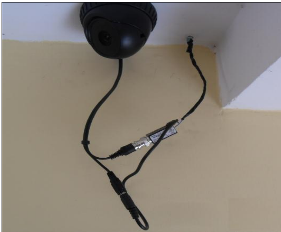
fig. 20: Conexión del Valum con la cámara
