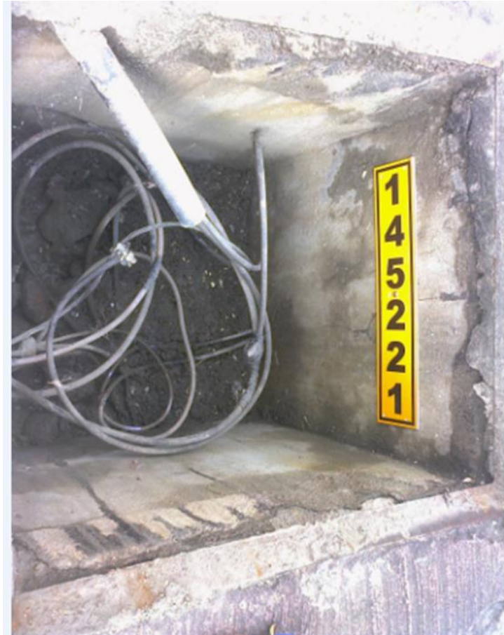
Anexo 7: Circuito de media tensión subterráneo, colocación de placa numérica y recopilación de datos
