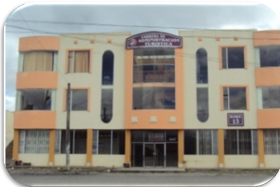
Figura 3. Instalaciones del Área Jurídica, Social y Administrativa.
