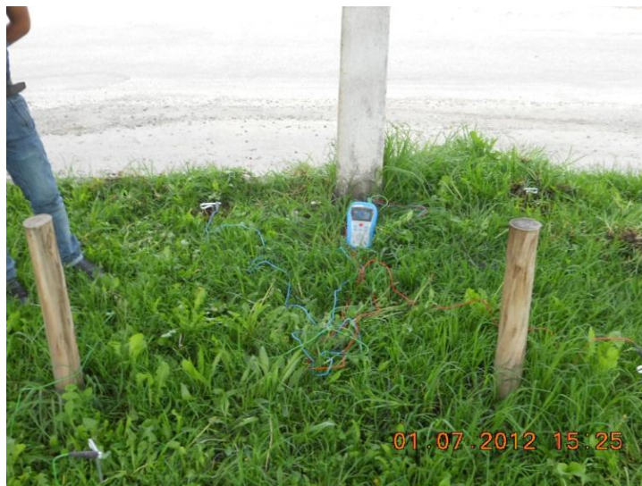
Figura 5.1. Fotografía de Medición de Resistencia de un Terreno
