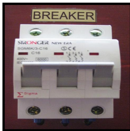
Figura 22 (Breaker Stronger 3f)
