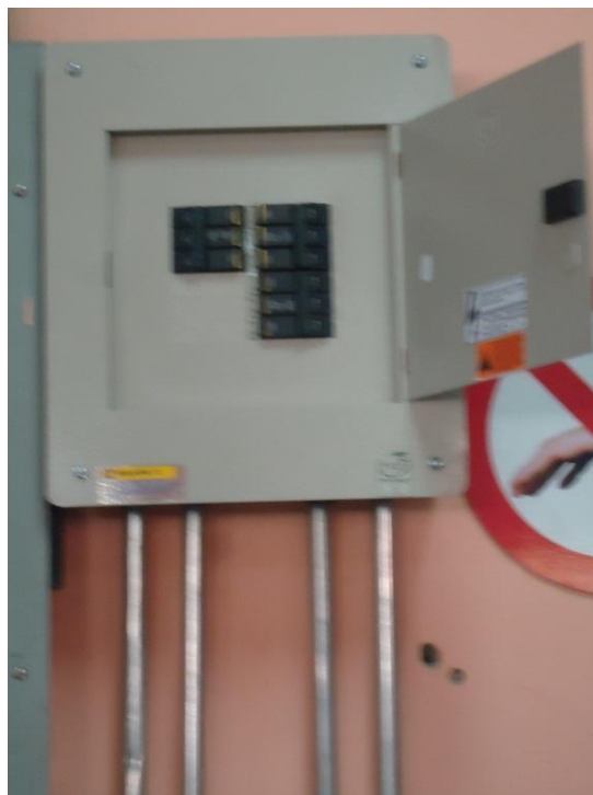
Armado del Tablero General de Distribución
