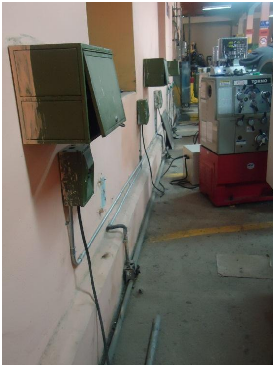
Instalación de la nueva maquinaria
