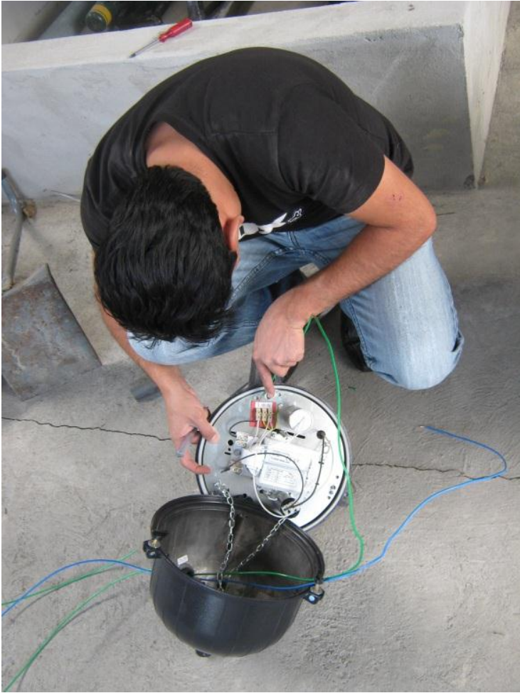
Fig. # 11. ARMADO DE LUMINARIAS
