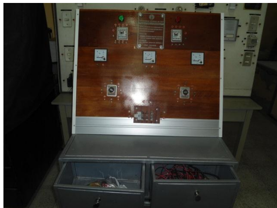
Montaje del tablero sobre el banco
