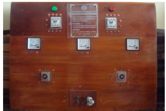
Montaje de instrumentos
