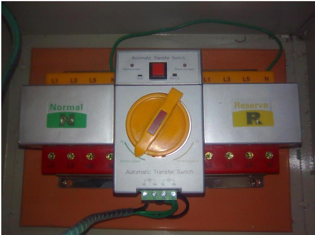
**Fotografía 4 Switch de transferencia de energía**
