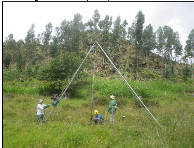
Fotografía 2.- Ensayo de penetración estándar.
