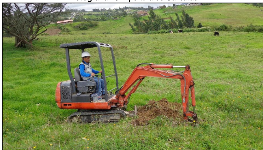
Fotografía 10.-Apertura de Calicatas
