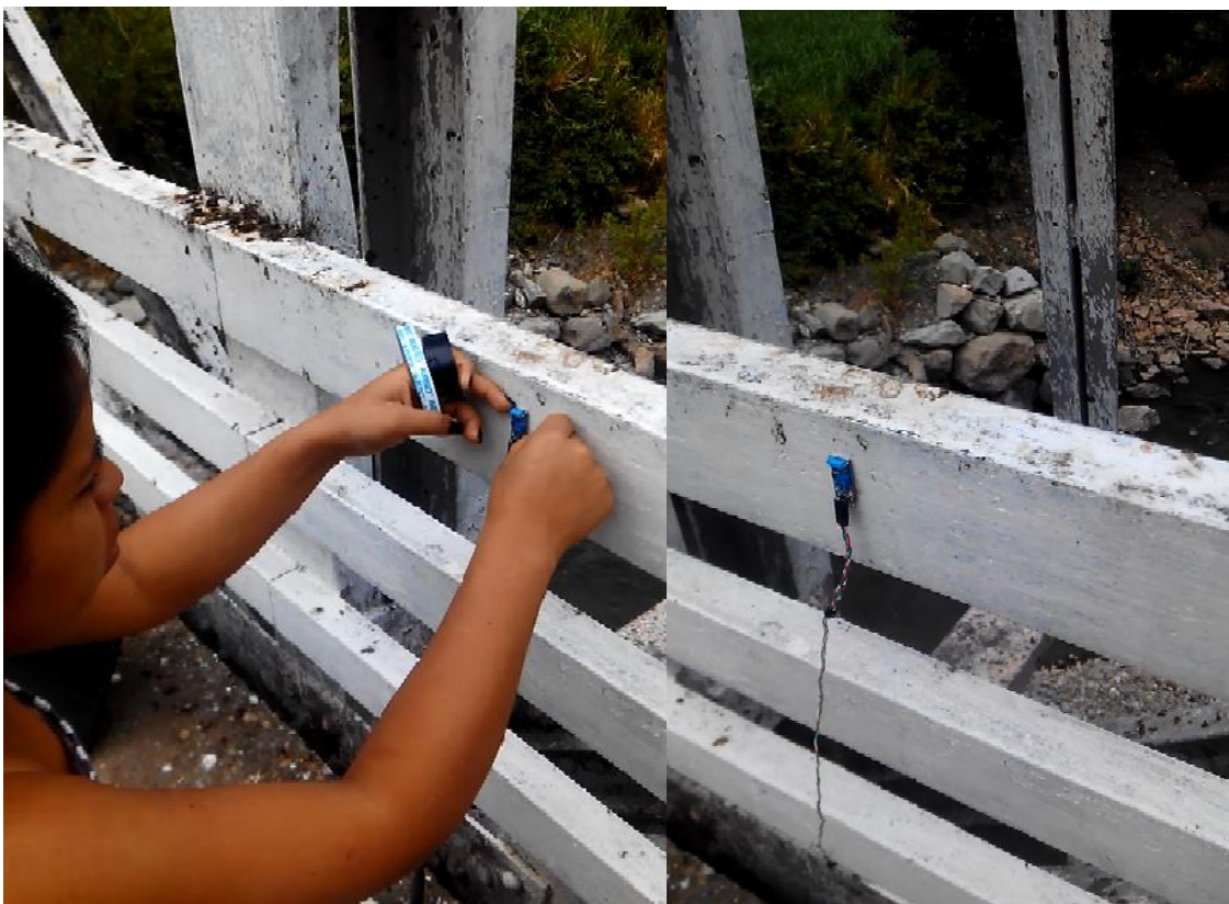
Figura 56. Ubicación del sensor de vibración sobre la estructura.
