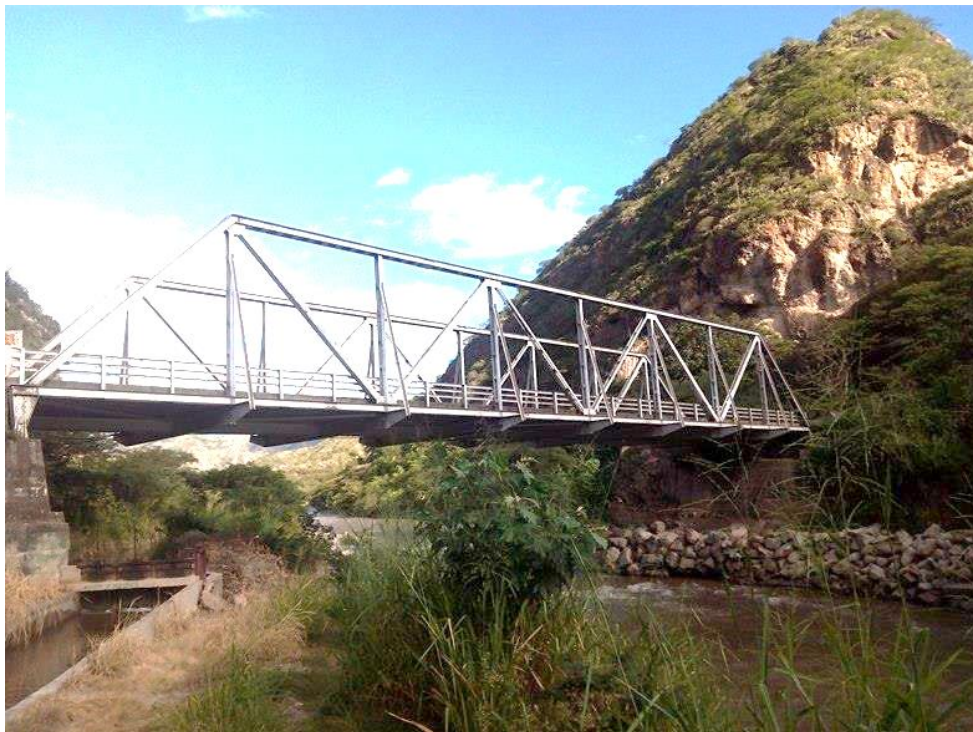
Figura 68. Estructura de monitoreo, vista frontal.
