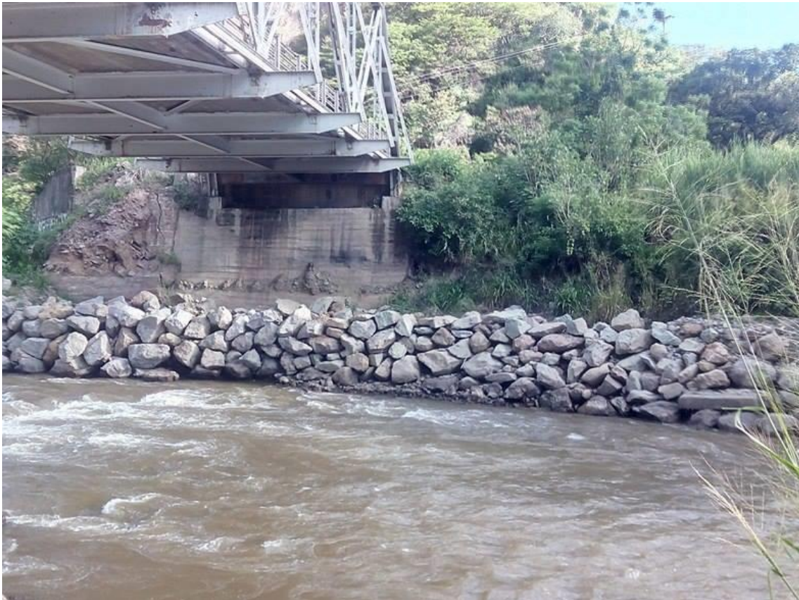
Figura 69. a) Corrosión en el acero de los elementos primarios de la estructura, b) Relleno en socavación presente en el estribo izquierdo.
