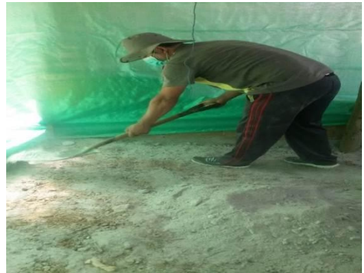
Fotografía 8. Aspersión de la ceniza por todo el lugar a utilizar
