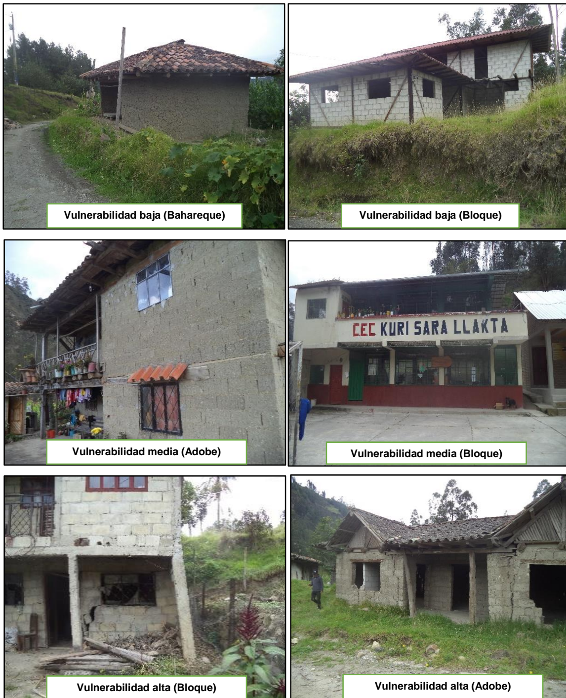
Fotografía 25. Tipología de viviendas y sus grados de vulnerabilidad. Fuente: El autor, 2016.
