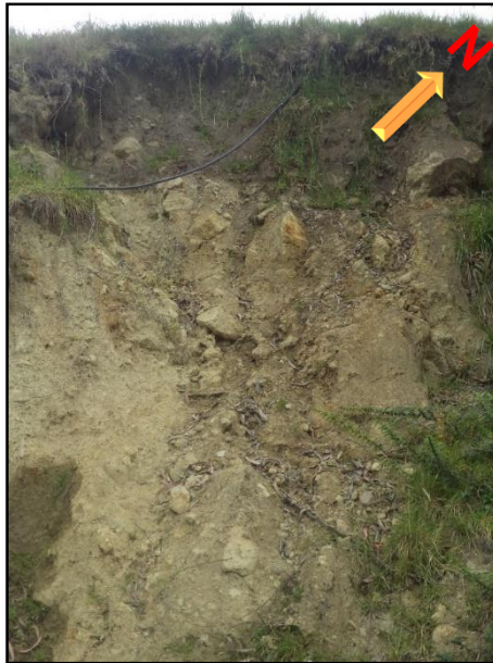
Fotografía 9. Escarpe de deslizamiento en coluvión. Fuente: El autor, 2016.
