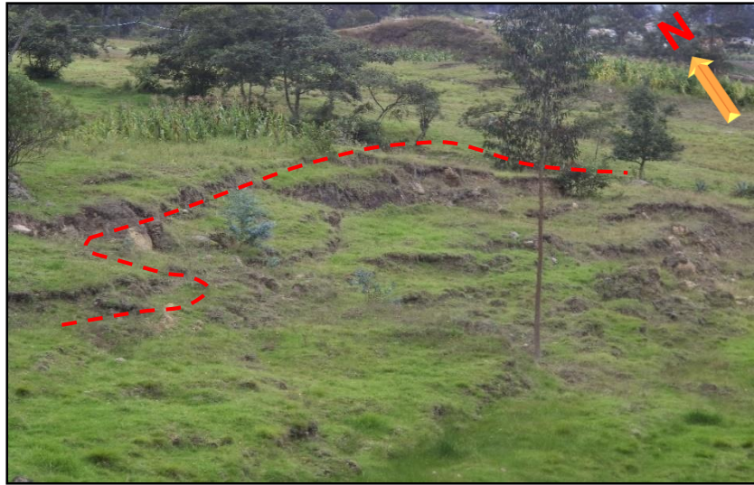
Fotografía 15. Escarpe de deslizamiento. Fuente: El autor, 2016.
