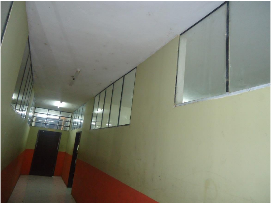
Ilustración 66: Ubicación del rack segundo piso B3
