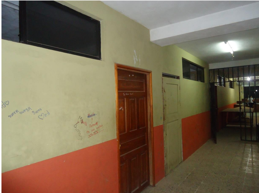
Ilustración 73: Ubicación del rack Segundo piso B4
