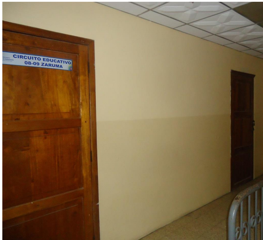
Ilustración 59: Ubicación del rack cuarto piso B1
