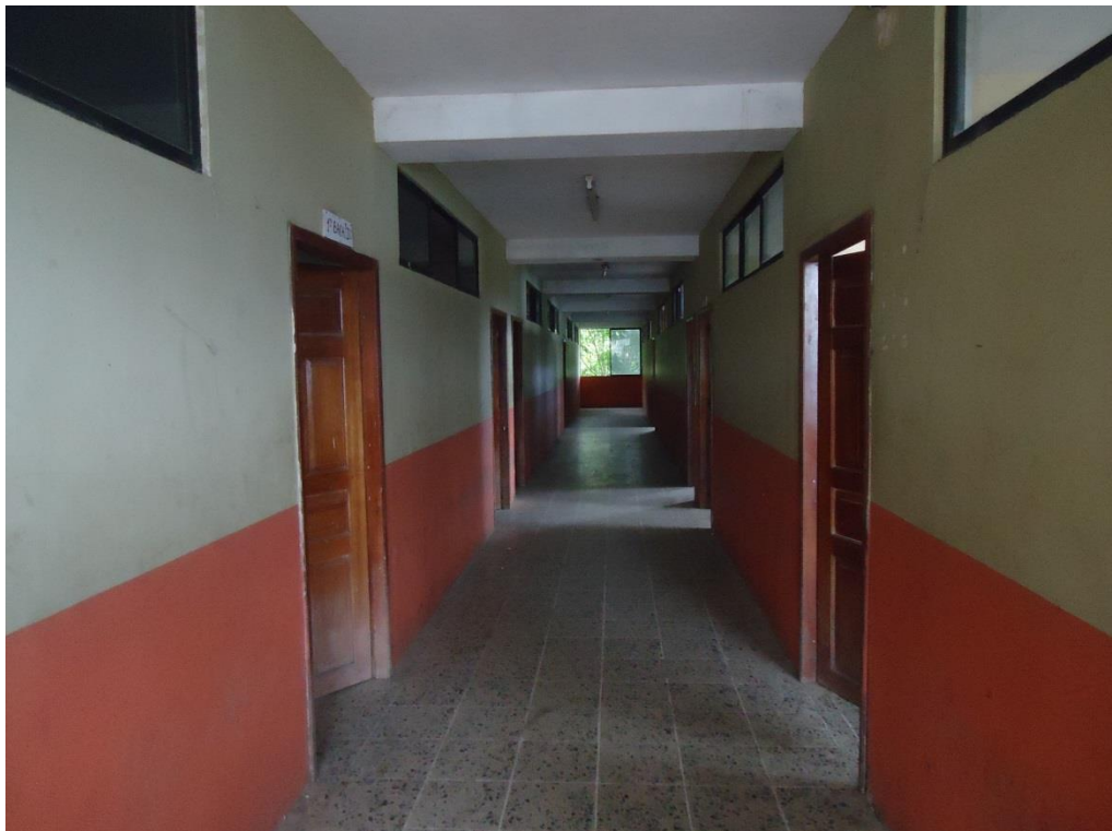
Ilustración 72: Ubicación del rack Tercer piso B4
