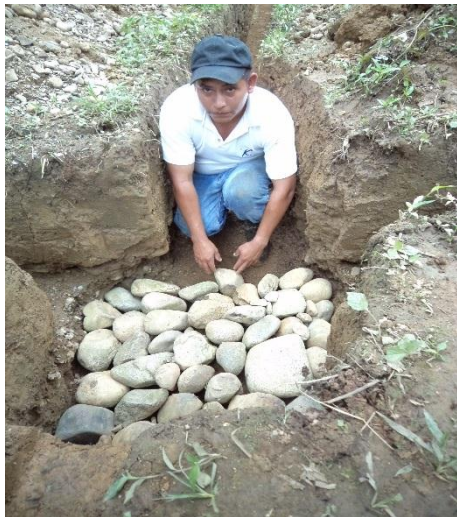
Fotografía 16. Cimentación de la losa de concreto de 0,15 m de espesor
