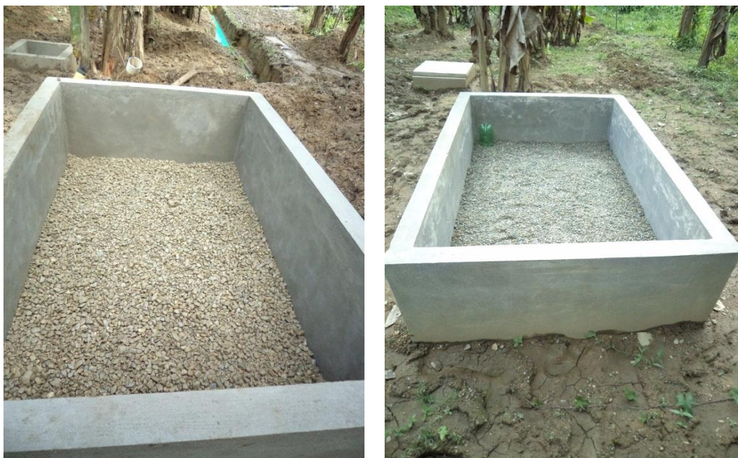
Fotografía 26. Colocación de una capa de grava de \frac{3}{4} " y \frac{1}{2} " y arena de 1,3 mm en el lecho de secado de lodos
