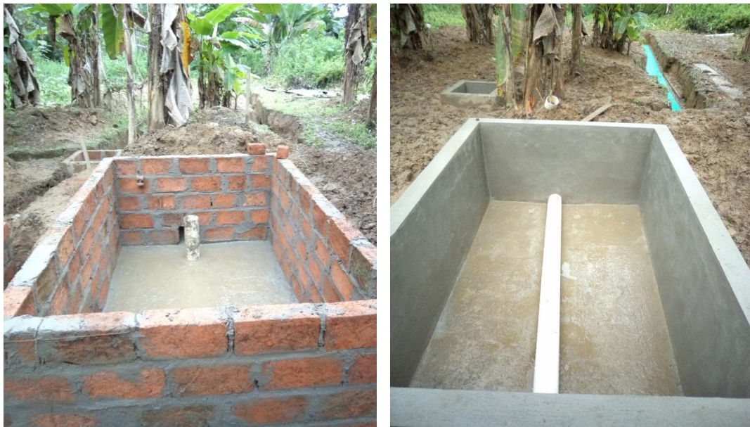
Fotografía 25. Armado, colocación de tubo PVC y revestido del lecho de secado de lodos
