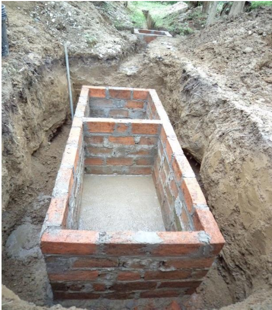
Fotografía 14. Armado de las cámaras con paredes de ladrillo
