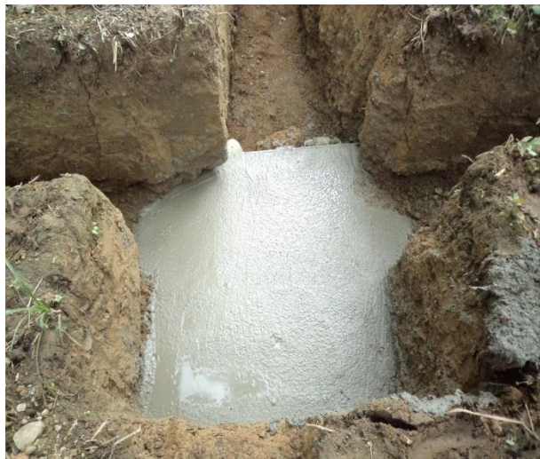
Fotografía 16. Cimentación de la losa de concreto de 0,15 m de espesor
