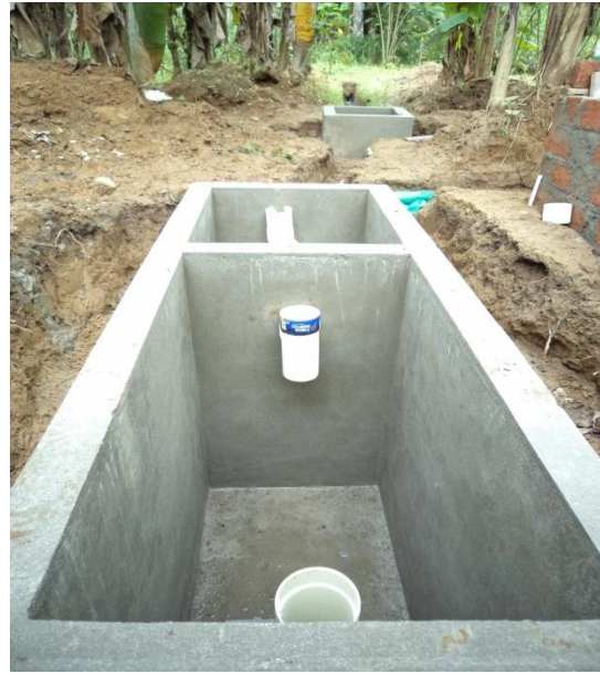
Fotografía 15. Revestido del tanque séptico
