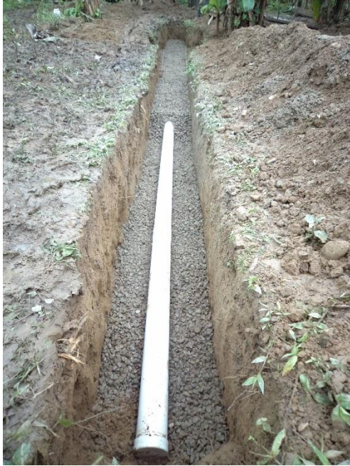
Fotografía 21. Colocación de grava de \frac{3}{4} " y tubería de 100 mm en la zanja
