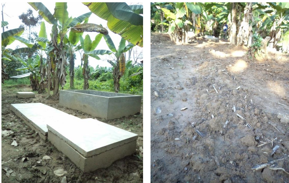
Fotografía 27. Puesta en marcha y funcionamiento la zanja de infiltración
