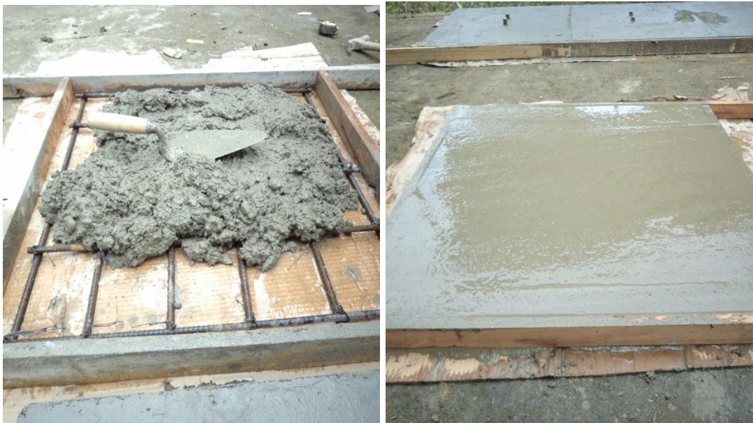
Fotografía 18. Construcción de tapas de hormigón armado de 0,80 x 0,80 m de dimensión x 0,07 m de espesor
