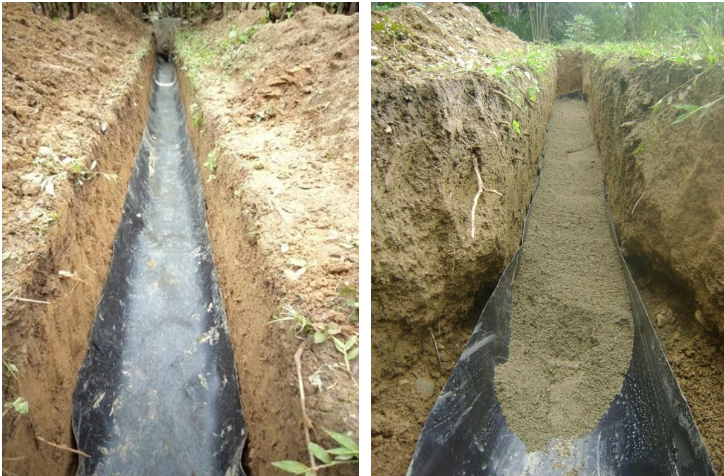
Fotografía 20. Colocación de geomembrana y arena de río en la zanja
