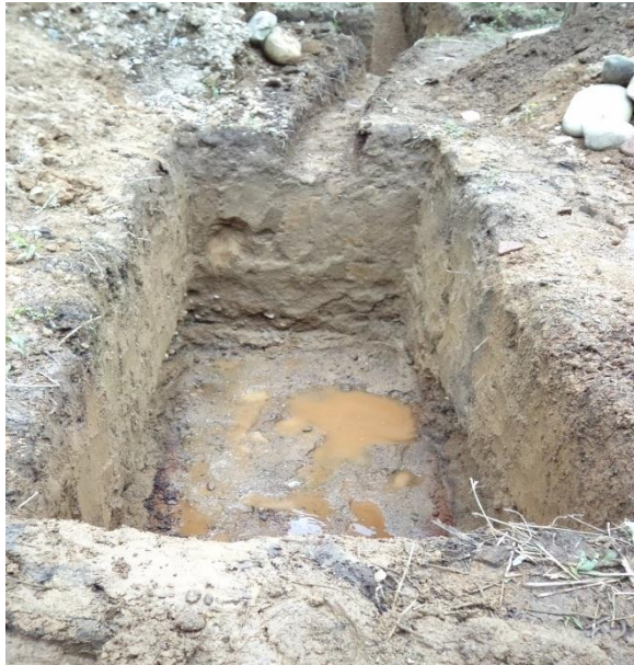
Fotografía 12. Excavación del pozo para construir el tanque séptico
