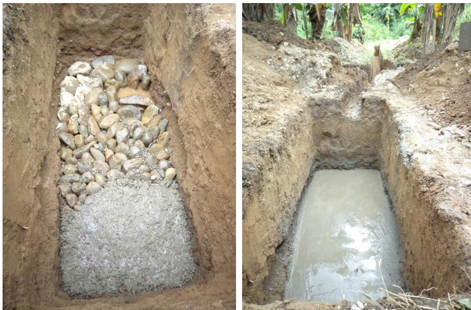
Fotografía 13. Construcción de la losa de concreto de 0,15 m de espesor
