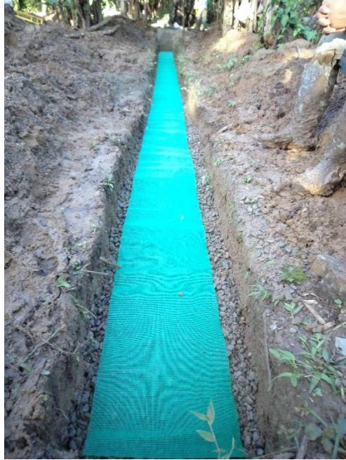
Fotografía 22. Llenado con grava la red de tubería y colocación de una malla plástica
