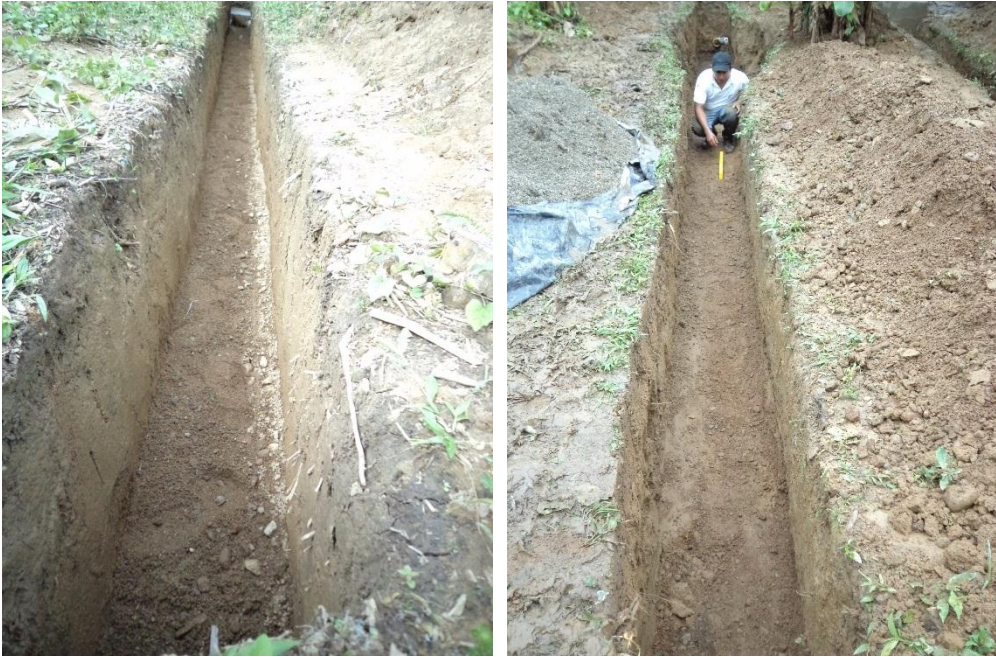
Fotografía 19. Excavación y nivelación de las zanjas
