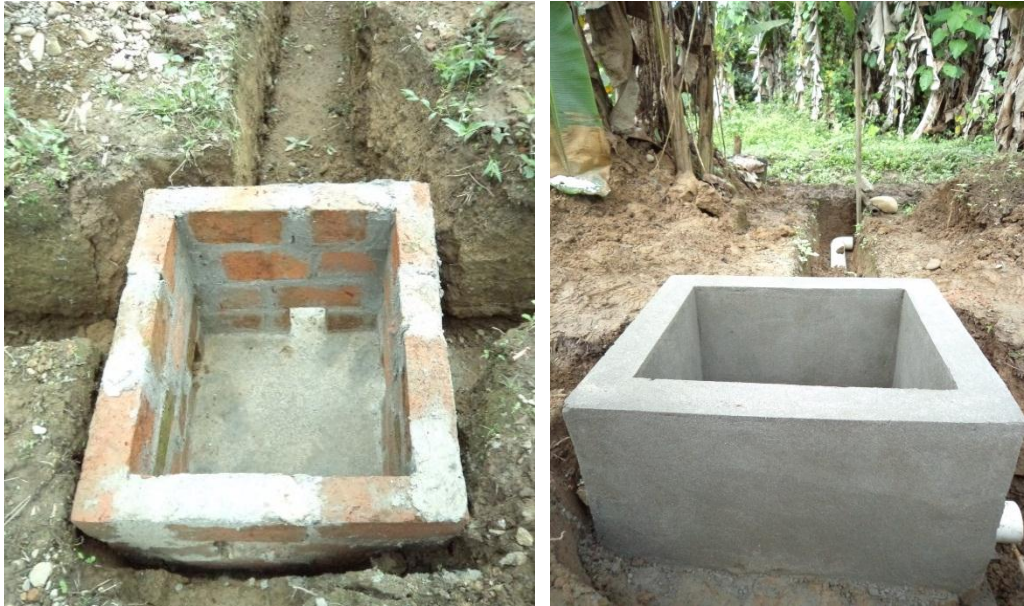
Fotografía 17. Armado, colocación de tubería y revestido de la caja de distribución
