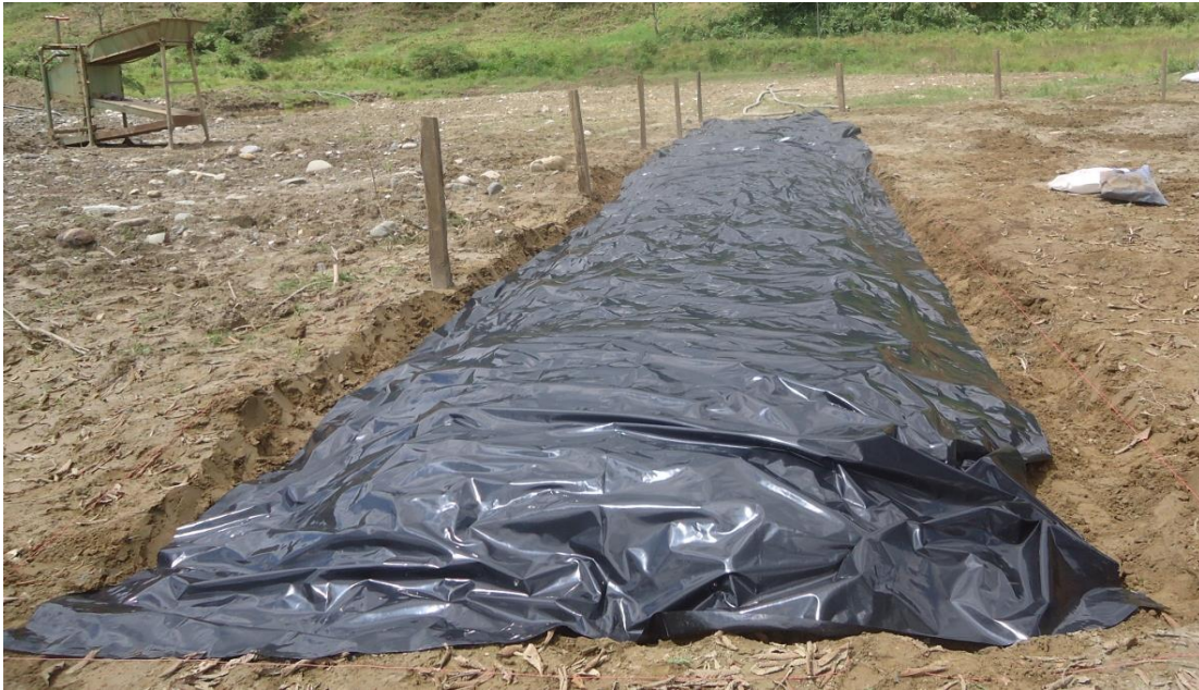
Fotografía 6. Proceso de elaboración de las biopilas in situ.
