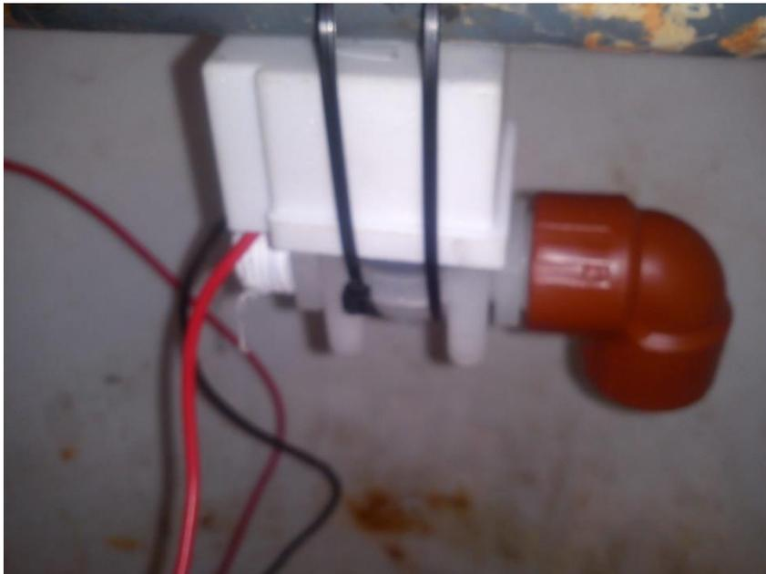
*Fig. 16. Electroválvula para apertura del paso de agua.*
