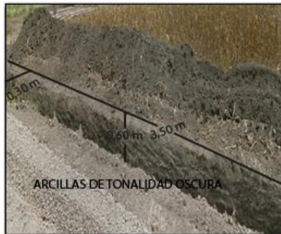
Figura 22.- Calicata de arcillas de tonalidades oscuras Fuente: El Autor (2016)
