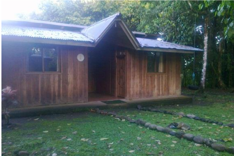
Parte Externa de las Cabañas de Hospedaje del Campamento Victoria
