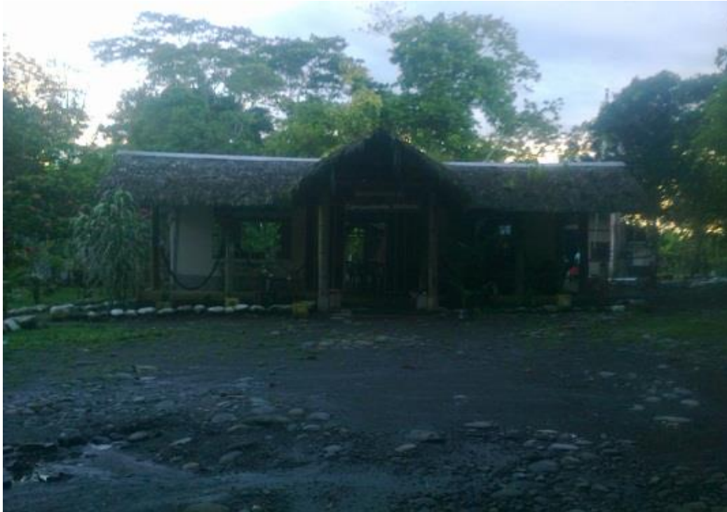
Exteriores del Restaurante del Campamento Victoria
