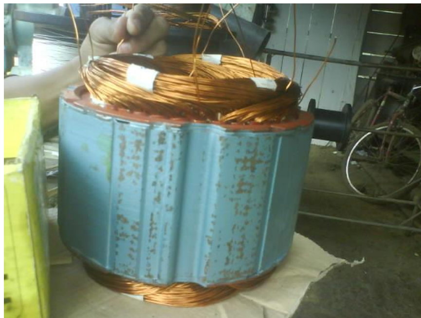
Fig. 1.93 Terminación del proceso de rebobinado
