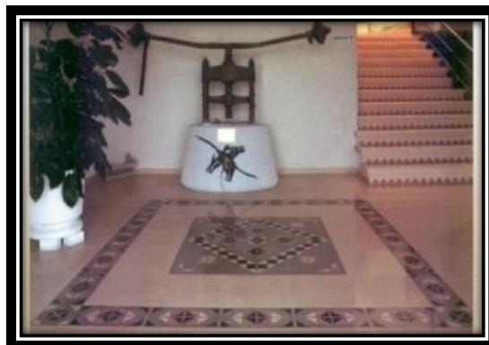
Fig. 1.1 Piso de una vivienda con baldosas de cemento
