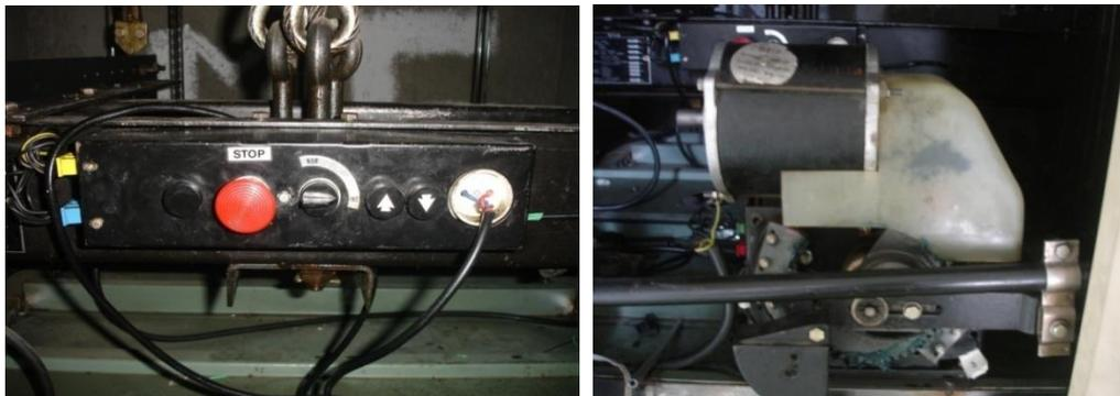
*Figura # 7. Control de Mantenimiento y Motor de Puertas*
