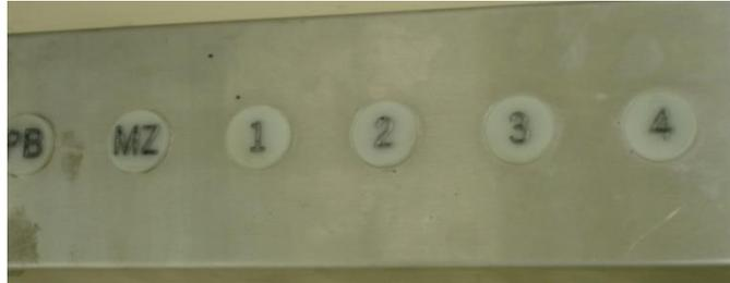
*Figura # 6. Indicador de Posición Cabina*
