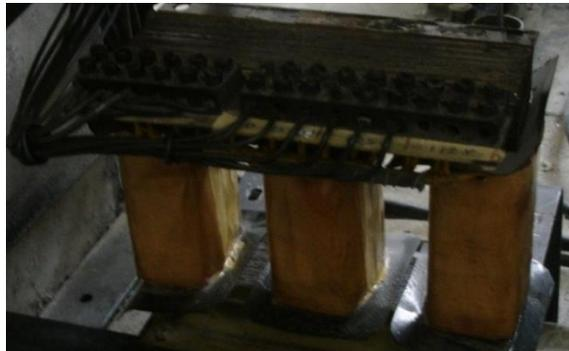
*Figura # 52. Transformador Trifásico*
