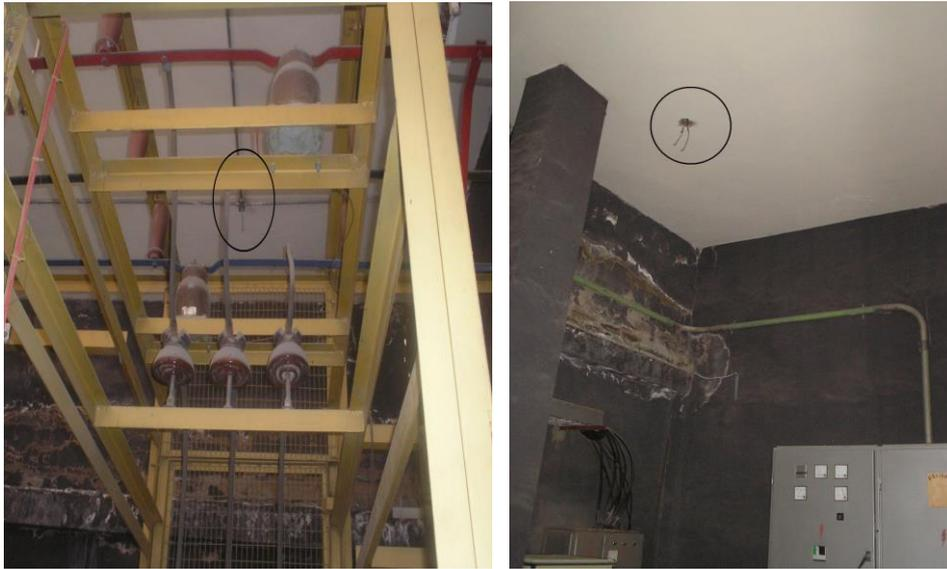
*Figura. 2.37 Ausencia de luminarias en el Centro de Transformación y Tableros Generales*
