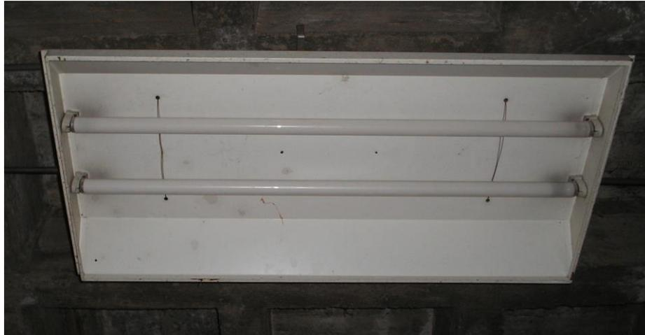
*Figura. 2.34 Luminarias con Balastro Electrónico existentes en el HIA (Lavandería)*
