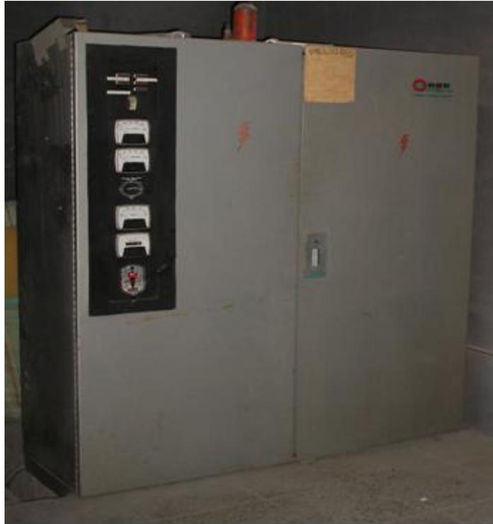
*Figura 2.3. Tablero de Transferencia ONAN*
