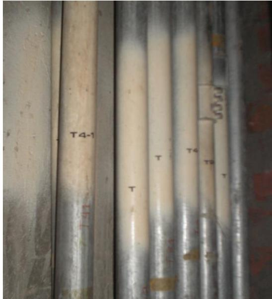
Figura 2.10. Tuberías EMT utilizada en alimentadores secundarios (1¼ pulg de diámetro)
