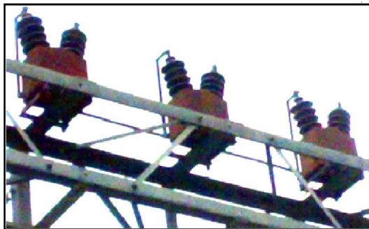
Figura 2.19 Transformadores potenciales
