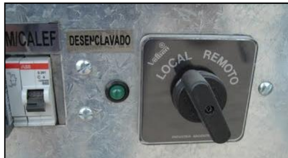
Figura 1.17 Interruptor rotatorio
