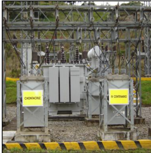
Figura 2.16 Interruptores de gran volumen de aceite
