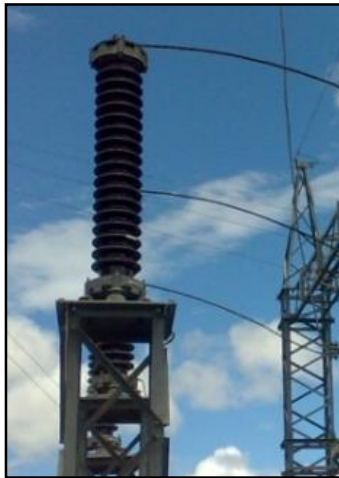
Figura 2.3 Descargador Valvular
