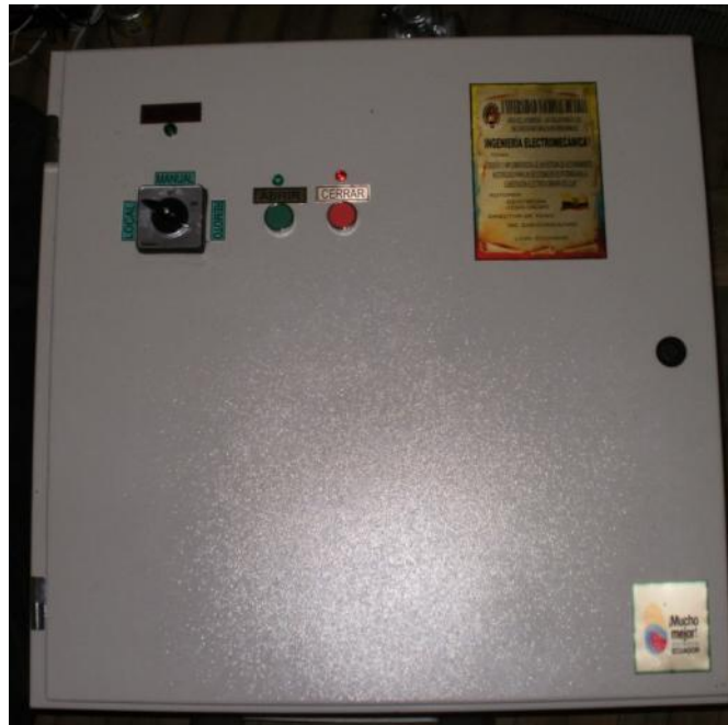
Fig. 3.17 Disposición física del seccionador de potencia
