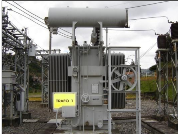
Figura 2.14 Transformador de potencia y su símbolo eléctrico
