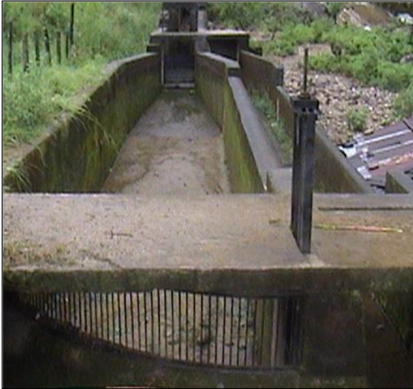
Fotografía 7 Obras de captación desarenador y rejilla de salida.
