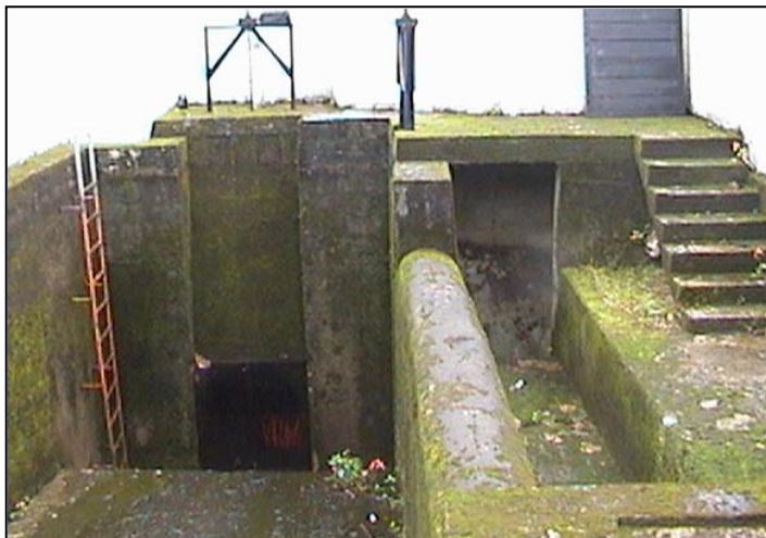
Fotografía 11 Obras de conducción Tanque de presión, vertedero y canal paralelo
