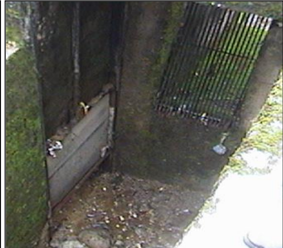
Fotografía 4 Obras de captación compuerta de limpieza y rejilla de entrada al desarenador.
