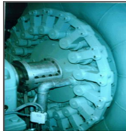
Turbina Francis de eje horizontal. Fig. 16. Eje de una turbina Francis Fig. 17
