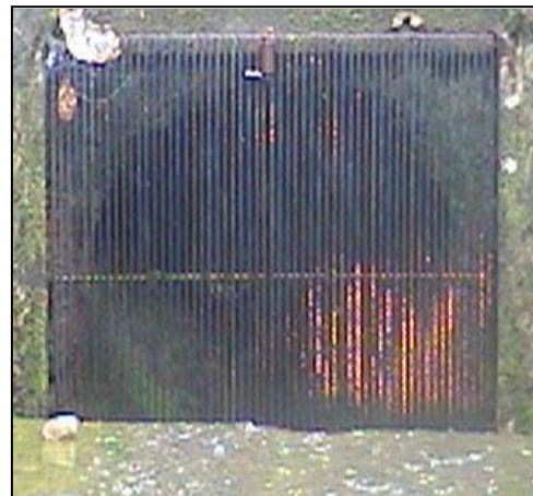
Fotografía 12 Obras de conducción Tanque de presión, compuerta de lavado y rejilla de entrada a la tubería de presión.
