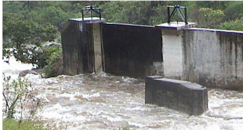
Fotografía 1 Obras de captación Azud y compuerta de limpieza
