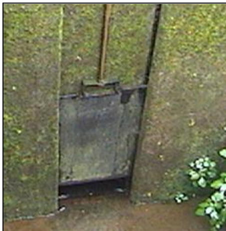
Fotografía 12 Obras de conducción Tanque de presión, compuerta de lavado y rejilla de entrada a la tubería de presión.
