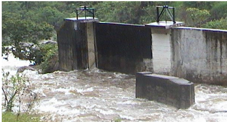
Fotografía 1 Obras de captación Azud y compuerta de limpieza
