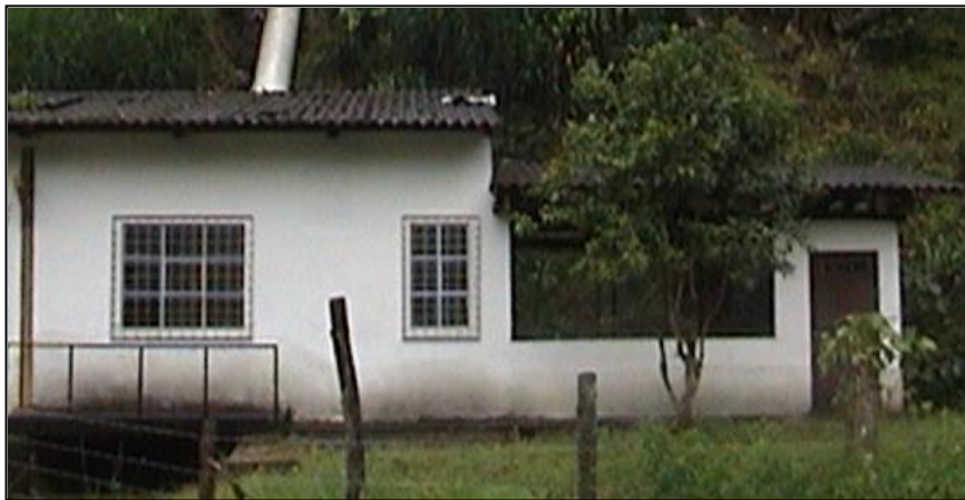
Fotografía 15 Casa de Máquinas, perpendicular a la tubería de presión
