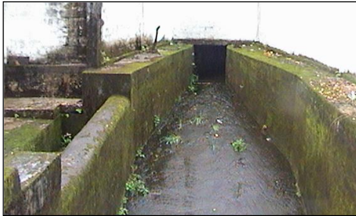
Fotografía 10 Obras de conducción Tanque de presión, transición de entrada
