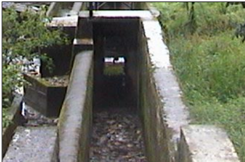
Fotografía 3 Obras de captación desripiador
