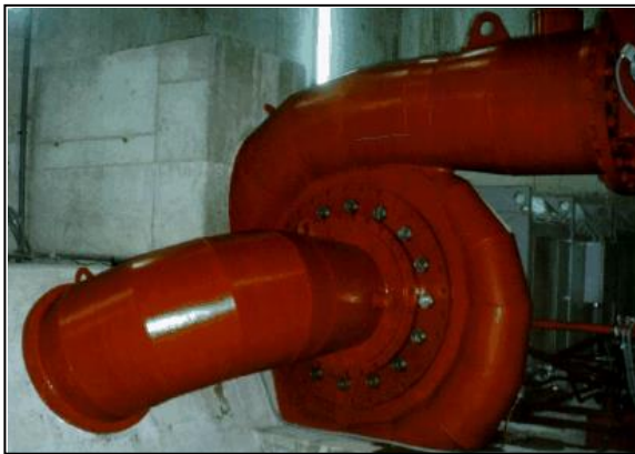
Turbina Francis de eje horizontal. Fig. 16. Eje de una turbina Francis Fig. 17
