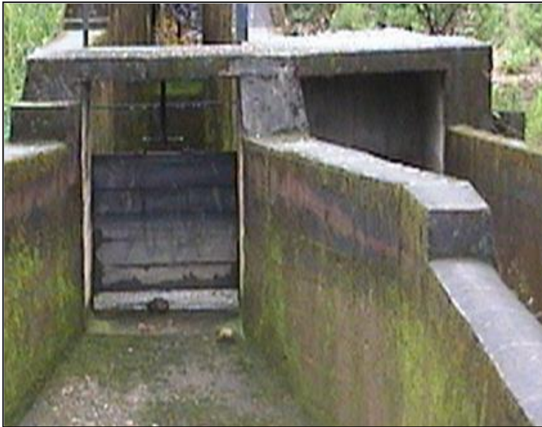
Fotografía 5 Obras de captación Compuerta de entrada al desarenador.
