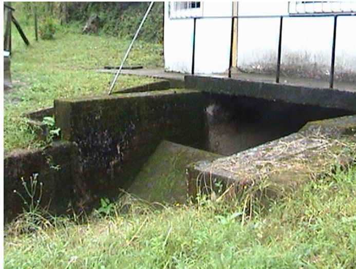
Fotografía 16: Canal de Restitución
