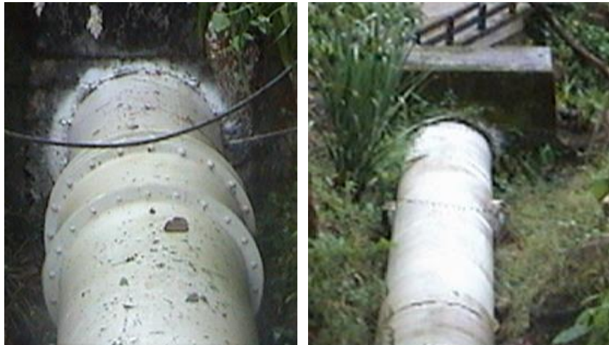
Fotografía 13 Obras de conducción Tubería de presión a la salida del tanque y bloque de anclaje.
