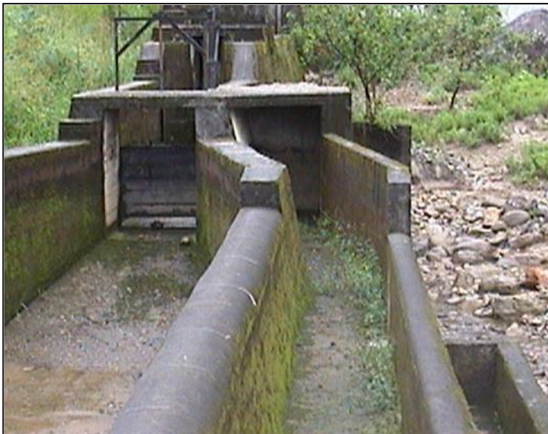
Fotografía 6 Desarenador y aliviaderos
