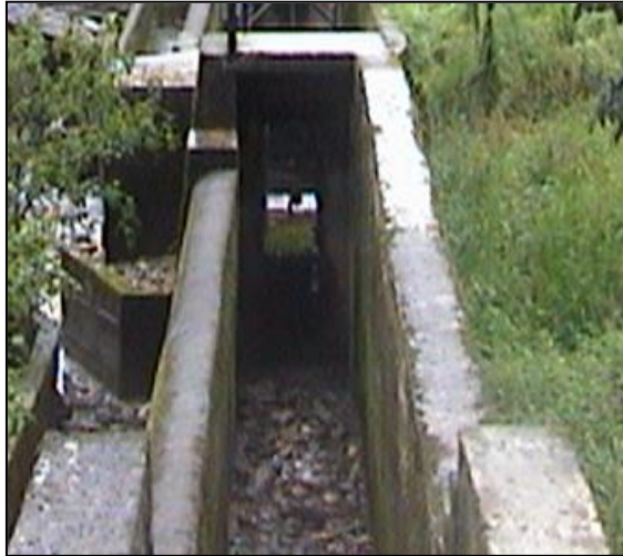
Fotografía 3 Obras de captación desripiador
