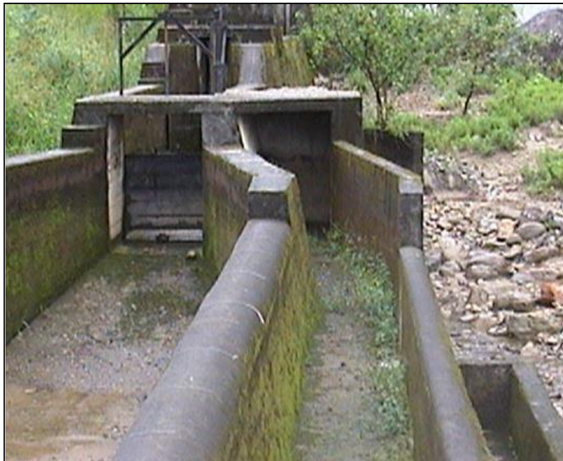
Fotografía 6 Desarenador y aliviaderos
