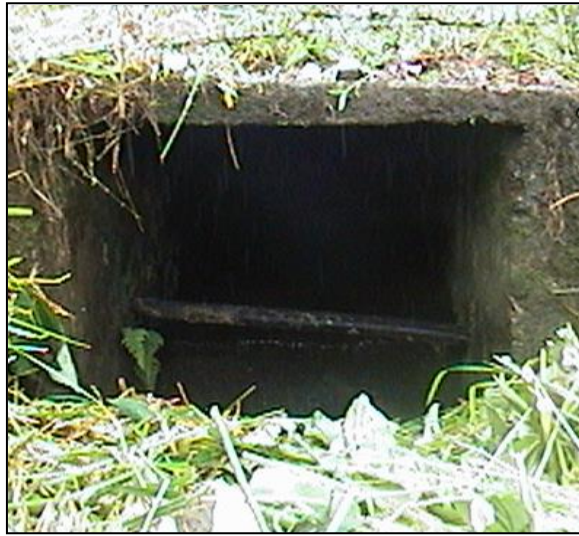
Fotografía 9 Obras de conducción canal embaulado de 510 m de longitud.
